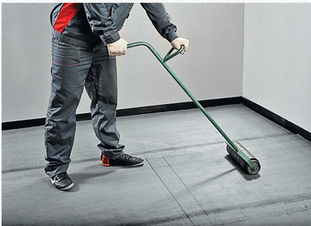
Нанесите герметизирующую мастику ТЕХНОНИКОЛЬ №71 на уложенный материал на расстоянии 80–100 мм от вертикальных поверхностей.
