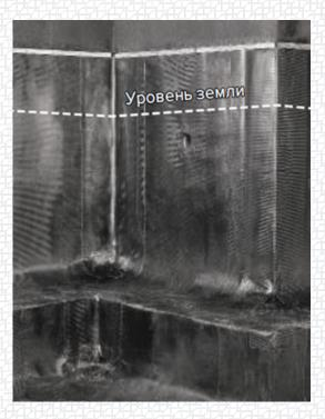
Верхний край гидроизоляционной мембраны закрепите к конструкции в цокольной части сооружения профилированной металлической краевой рейкой механическим путем.
