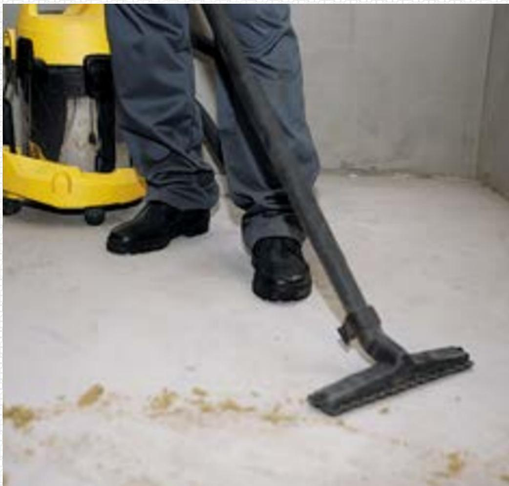
**Важно! В соответствии с СП 71.13330.2017 «Изоляционные и отделочные покрытия» Праймер ТЕХНОНИКОЛЬ №01 наносится на монолитное основание с влажностью по массе не более 5%.**
