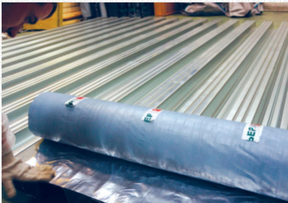
2. В случаях замасливания поверхности профлиста или плохой адгезии к основанию покройте верхние полки гофров Праймером битумно-полимерным ТЕХНОНИКОЛЬ №03.
