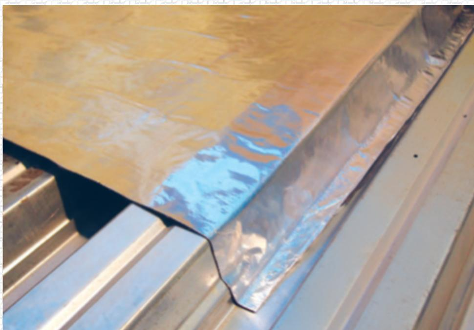
9. На пароизоляционный слой укладывайте утеплитель так, чтобы длинная сторона плиты была расположена перпендикулярно гофрам профнастила.
