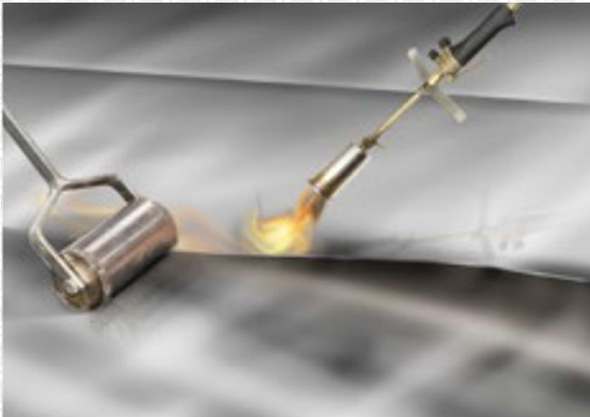
**Важно!** В случае последующей приклейки теплоизоляционного слоя к пароизоляции свободная укладка со сваркой швов не допускается.
