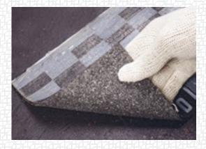
Важно! Приплавьте полосу точечно с одной стороны шва для того, чтобы в процессе укладки кровельного материала не было смещения.
