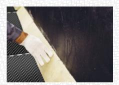
В случае устройство основания из цементно-песчаной стяжки бортики могут быть выполнены из цементно-песчаного раствора M150 с катетами 100х100 мм, при этом наклонную поверхность бортика необходимо праймировать.
