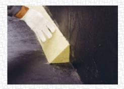
При устройстве кровли методом механической фиксации нижнего слоя, наклонные бортики (ТЕХНОРУФ В60 ГАЛТЕЛЬ) устанавливаются на предварительно разогретый пламенем горелки материал, подведенный к парапету.
