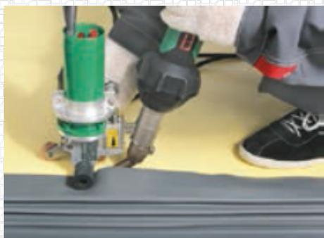
Прилагая необходимое усилие к рукоятке аппарата, плавно ведите аппарат вдоль шва. Следите за тем, чтобы края гидрошпонки равномерно приваривались к поверхности мембраны.
