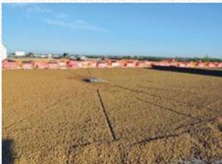
По уклонообразующему слою укладывается армирующая сетка из проволоки ВрЗ размером ячейки 150x150 мм и выполняется стяжка из цементно-песчаного раствора.
