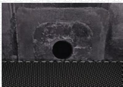
16. Установите наклонные бортики (ТЕХНОРУФ В60 ГАЛТЕЛЬ) к парапетной воронке на горячую мастику. Создайте плавный переход от наклонной поверхности бортика к вертикальной поверхности дополнительного слоя.
