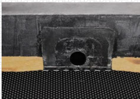
17. Наплавьте полосы слоя усиления из материала Техноэласт ЭПП на переходной бортик.
