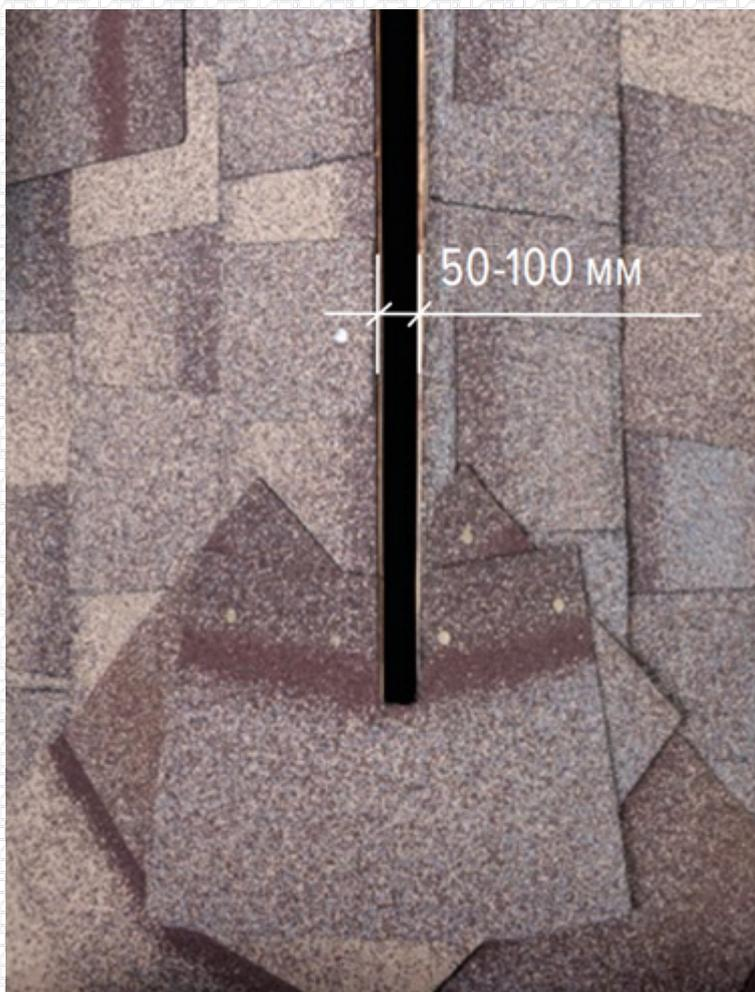
Фиксация аэроэлемента производится кровельными гвоздями или саморезами в местах, заранее размеченных на заводе-изготовителе. Длина конькового аэроэлемента составляет 610 мм, при необходимости можно соединять два или более аэроэлемента.
