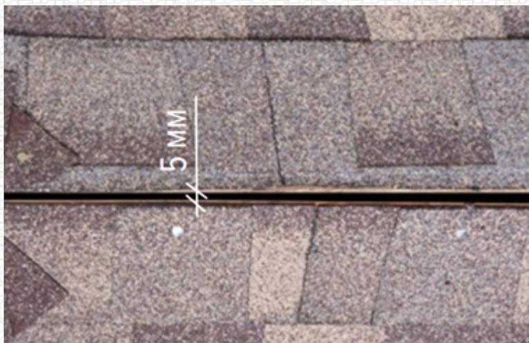
Укладываем коньково-карнизную черепицу снизу-вверх после отбивки габаритов будущего ребра (две полосы вдоль ребра) с помощью шнура (отбивки). Фиксируем каждую черепицу двумя или четырьмя гвоздями (по два с каждой стороны).
