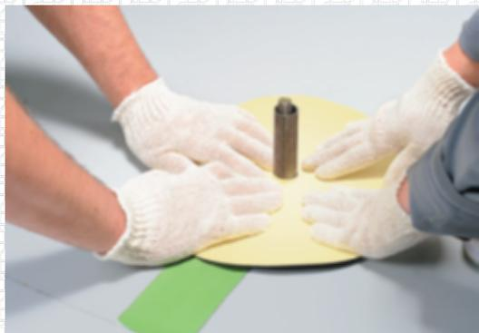
Прихватите заготовку точно в нескольких местах. Снимите фаску с краев заплатки на величину сварного шва (не менее **30 мм**).
