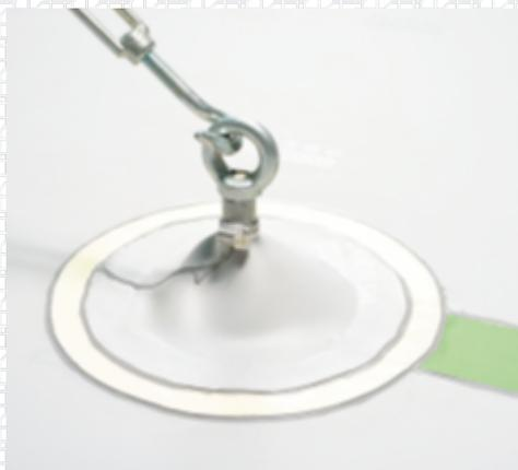
Сделайте разрез полотна мембраны, чтобы обойти проходку малого диаметра.
