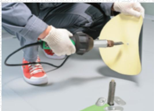
Затем быстро, пока мембрана не остыла, наденьте заготовку на проходку малого диаметра.
