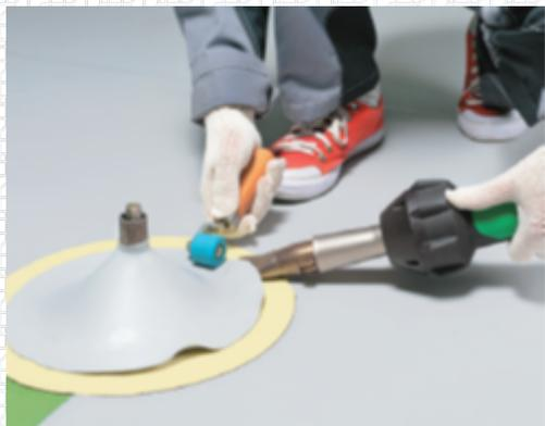
Проверьте качество сварных швов пробником. Сверху конус стяните хомутом и заполните ПУ герметиком. Обработайте швы жидким ПВХ.
