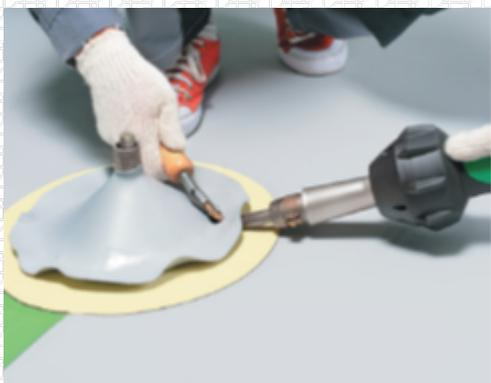
Приварите внешние края заготовки к основной мембране.
