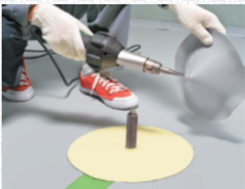
Быстрым движением, не допуская остывания мембраны, наденьте конус на элемент малого диаметра.
