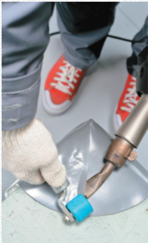
Затем прогревайте небольшой участок нижней части заготовки, водя соплом фена вдоль него, до тех пока мембрана не станет пластичной.
