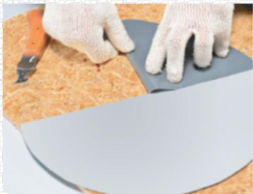
Отступив на **20 мм** от линии сгиба, сделайте разрез кровельным ножом.
