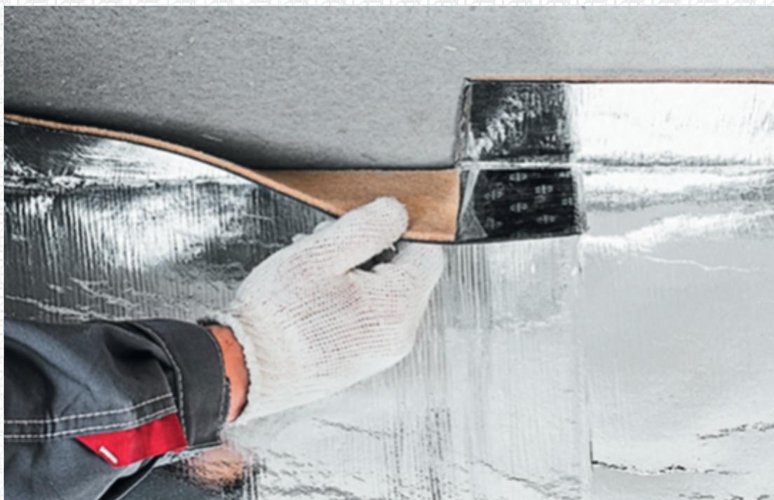
Следите за тем, чтобы звукоизоляционный слой вплотную прилегал к кромке соседнего рулона.
