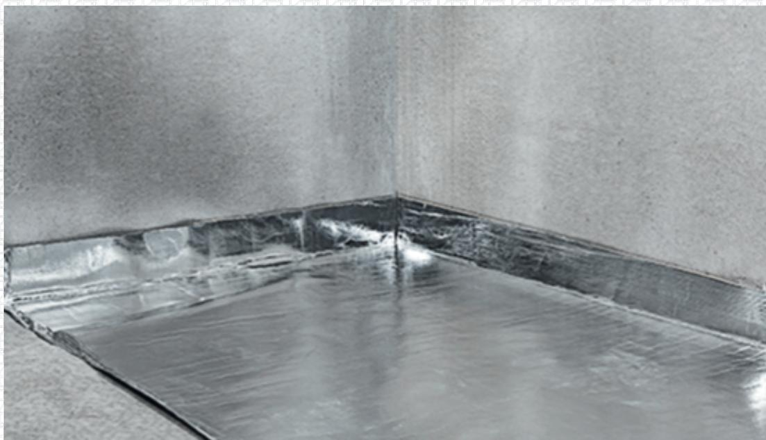
Согните материал ТЕХНОЭЛАСТ АКУСТИК СУПЕР, используя металлическую линейку или правило.
