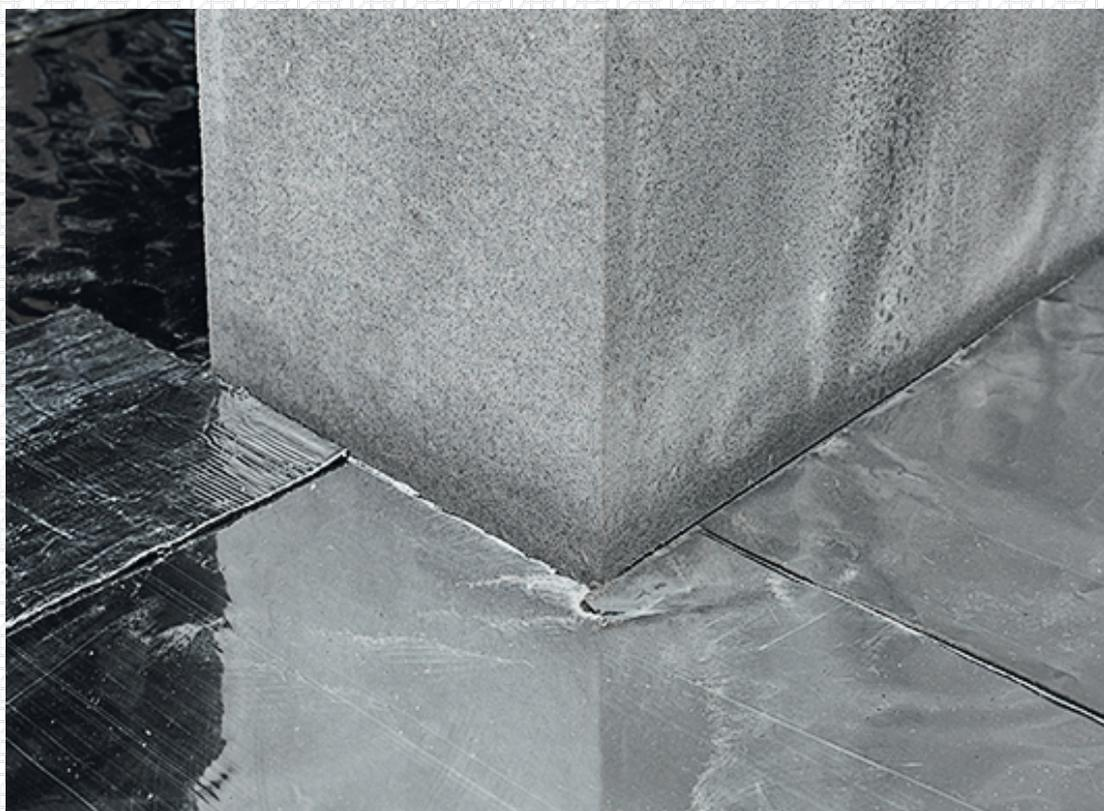
Установите демпферную ленту до края внешнего угла с одной стороны вертикальной
