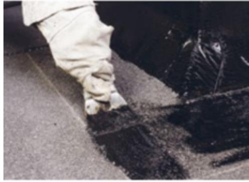
Наплавьте дополнительный верхний слой на всю плоскость парапета с одной стороны угла парапета.
