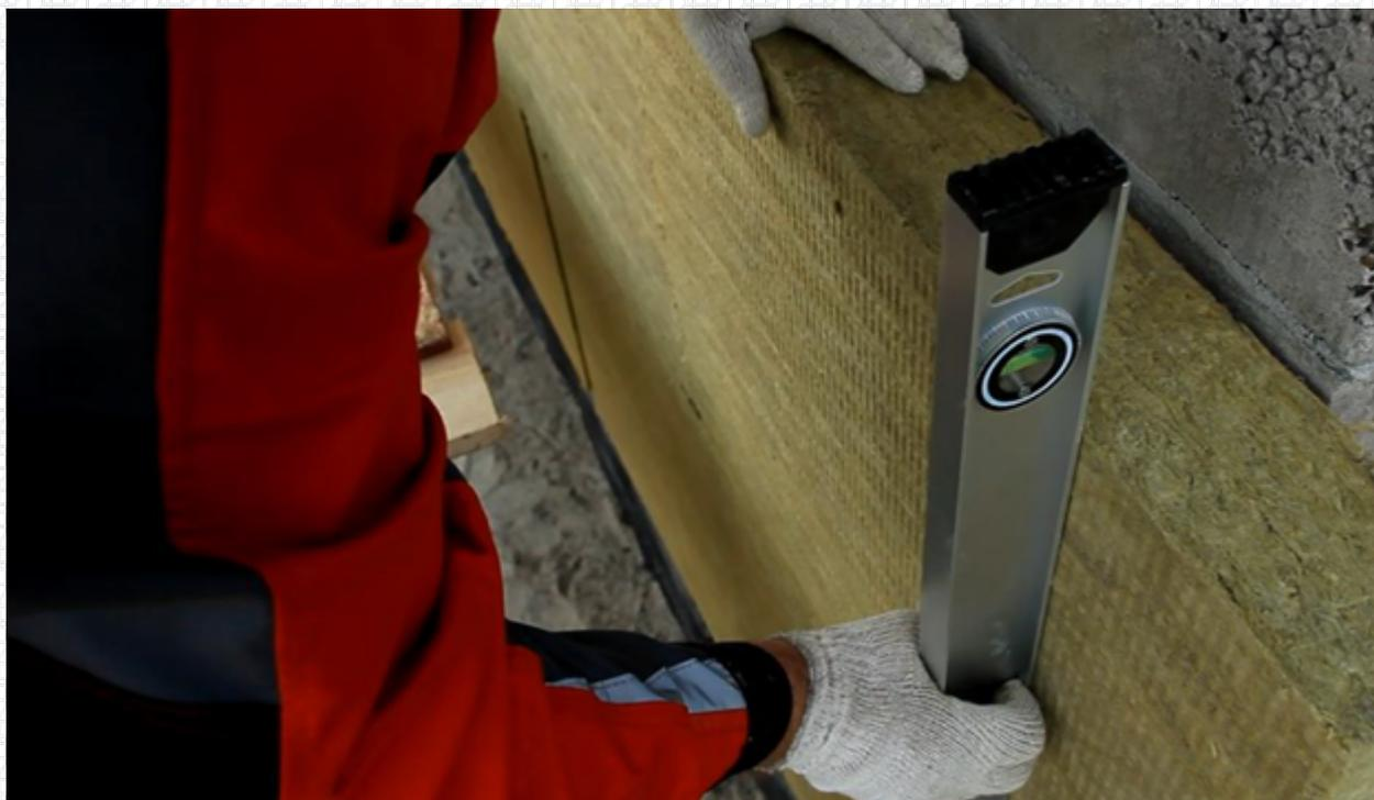
Щели между теплоизоляционными плитами ТЕХНОНИКОЛЬ CARBON ECO FAS необходимо заполнить полосами из используемого теплоизоляционного материала, вырезанными по размеру этих щелей, или полиуретановым клеем-пеной ТЕХНОНИКОЛЬ 500, или клей-пеной ТЕХНОНИКОЛЬ Professional для пенополистирола.
