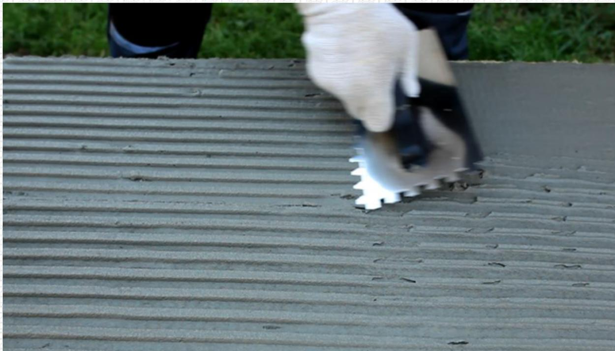
Сплошной метод нанесения клеевых смесей применяется, если основание имеет неровности до 3 мм.
