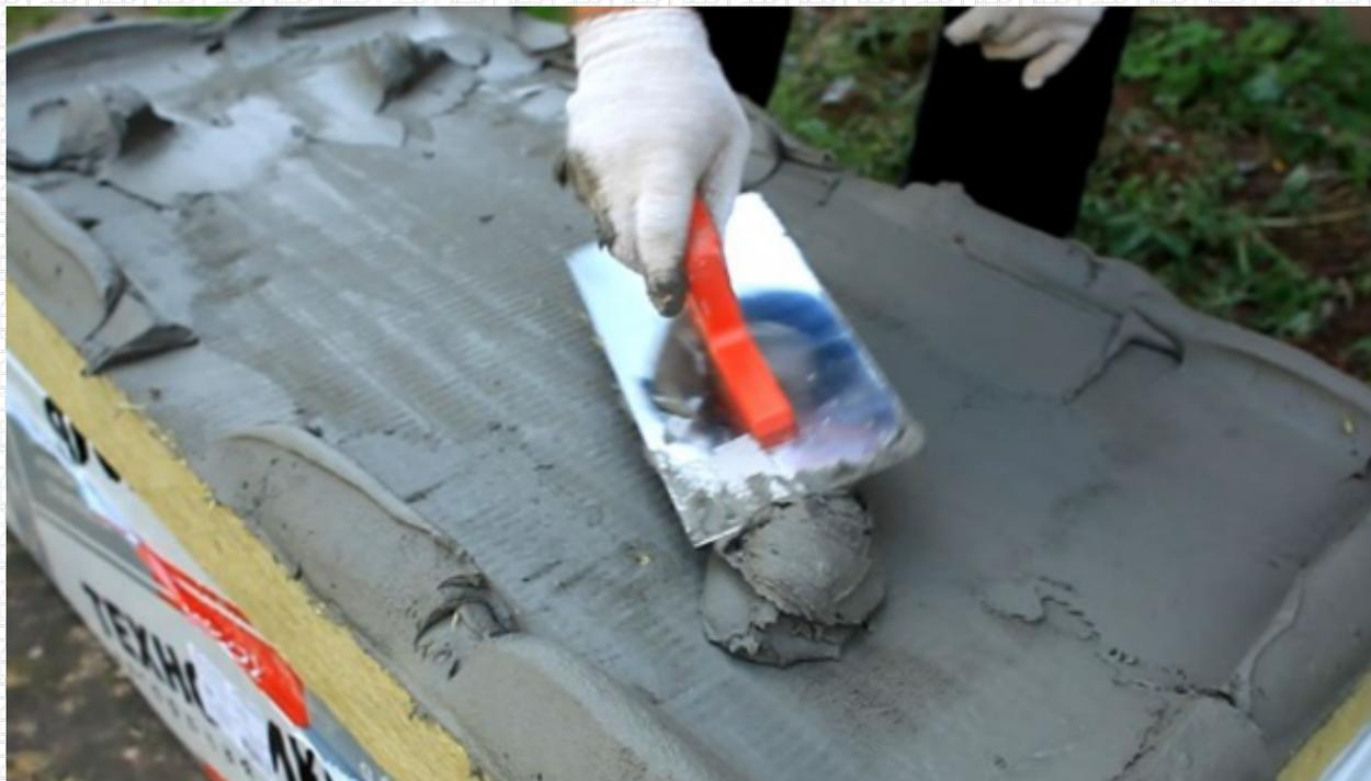
Контурно-маячковый метод нанесения клеевой смеси применяется, если основание имеет неровности от 3 до 30 мм.
