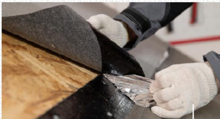
Плѐнка выполнена только по плоскости, которая образует продольный перехлѐст на ширину 100 мм
