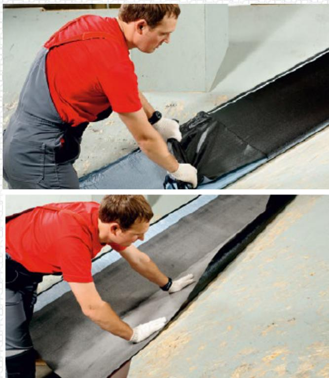
Пленка выполнена по всей плоскости подкладочного ковра. Ковёр, при монтаже полностью приклеивается к основанию и плёнка удаляется со всей поверхности.
