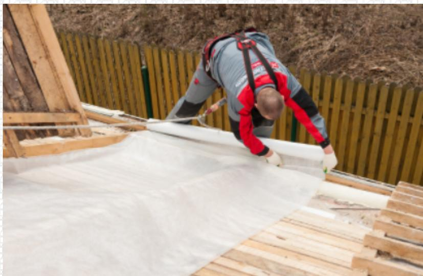
1. Первоначальное (временное) крепление пленки к древесине выполнить с помощью скоб из нержавеющей стали или оцинкованными гвоздями с плоской головкой.
