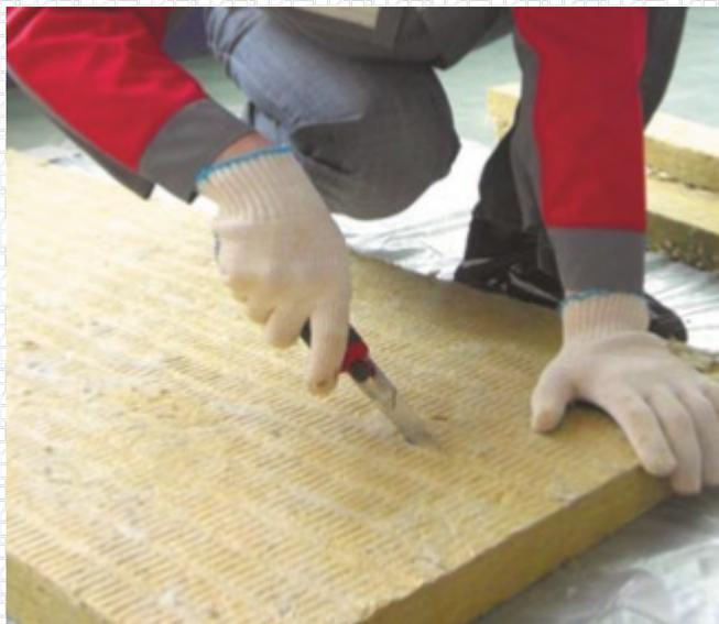
Плиты из каменной ваты не требуют дополнительной подготовки после вскрытия пачки, Плиты ТЕХНО ОЗМ полностью готовы к применению. При необходимости раскрой плит осуществляется ножом или пилой с мелкими зубьями.
