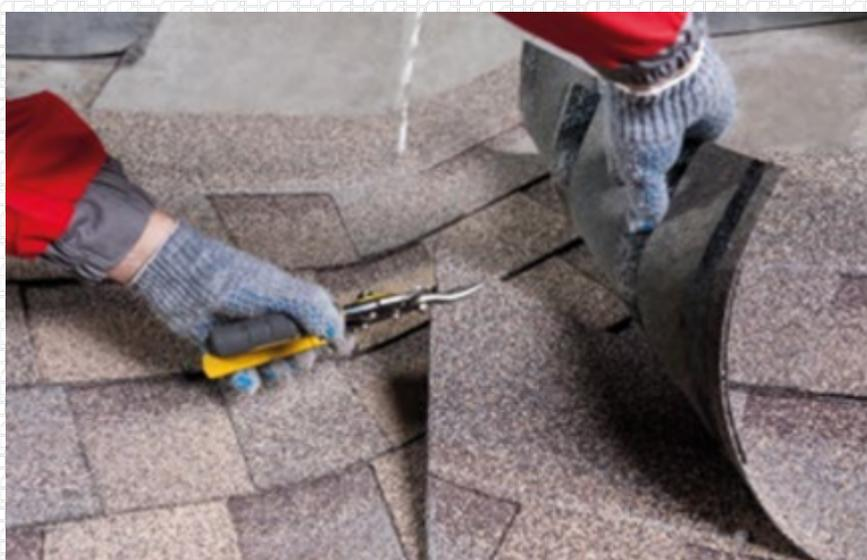
Промазать черепицу битумной мастикой ТЕХНОНИКОЛЬ Фиксер с тыльной стороны на величину 100 мм в местах отсутствия самоклеящегося слоя ,толщиной не более 1 мм.
