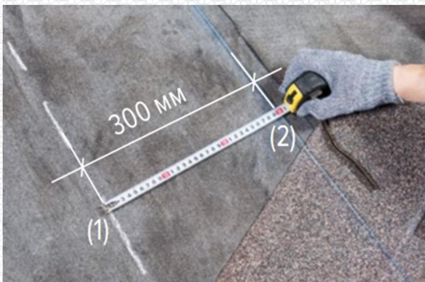
Уложить гибкую черепицу, начиная с малоуклонного ската с нахлестом на более крутой скат на величину не менее 300 мм. Произвести отбивку мелованной линии фиксации с помощью шнура (отбивки).
