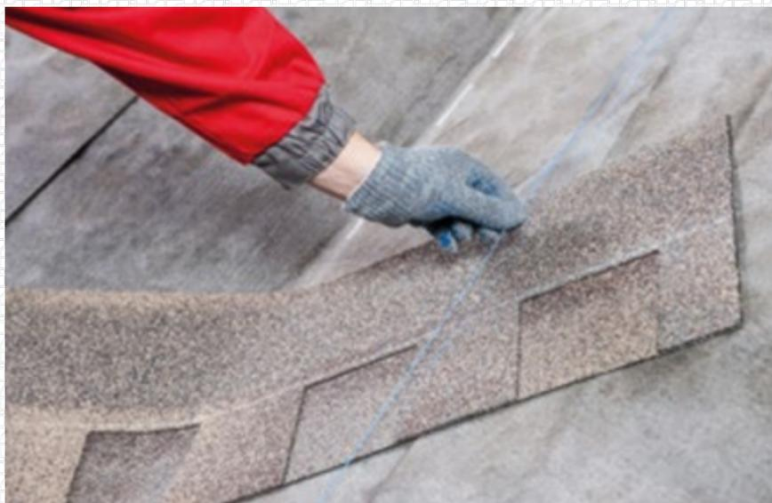
Зафиксировать каждый гонт гибкой черепицы с помощью кровельных гвоздей по линии фиксации (на расстоянии не менее 300 мм от оси ендовы).
