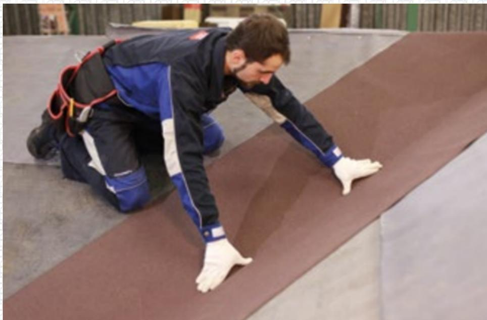
Зафиксировать с лицевой стороны эндовный ковер специальными кровельными гвоздями с отступом от края 20-30 мм с шагом 200- 250 мм.
