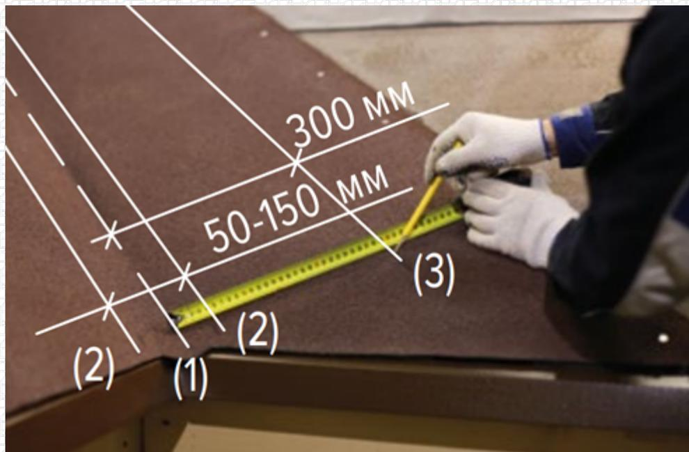
Произвести отбивку мелованных линий подреза и фиксации с помощью шнурки (отбивки).
