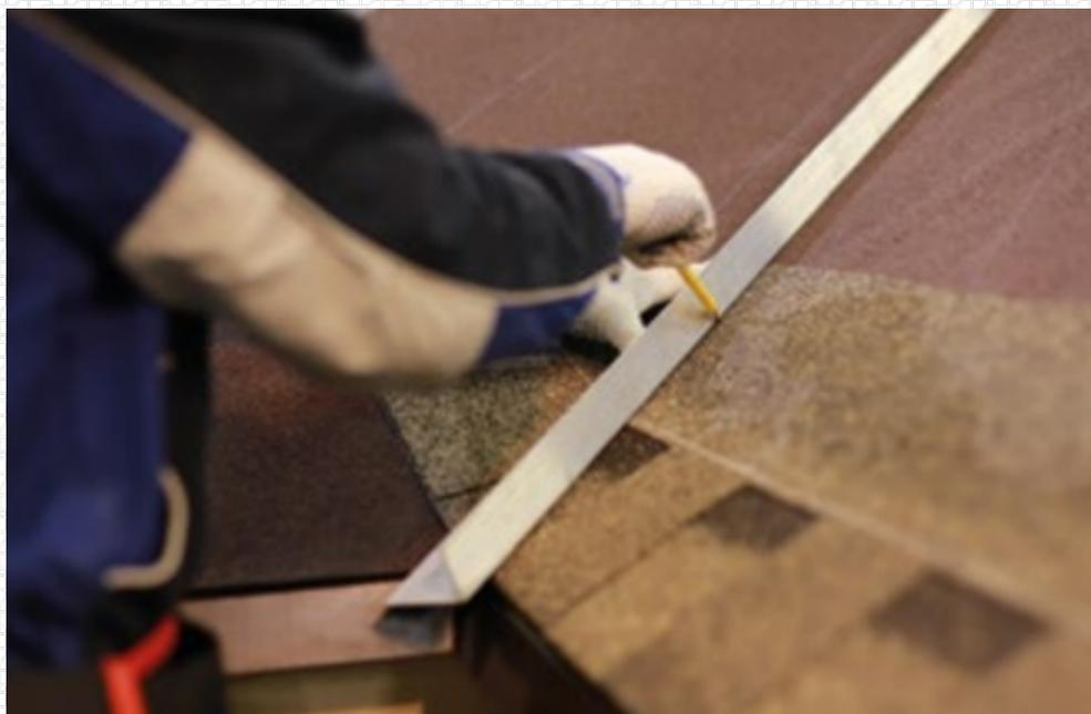
Подрезать рядовую черепицу по линии подреза, используя специальную деревянную дощечку, чтобы не повредить целостность гидроизоляционного слоя.
