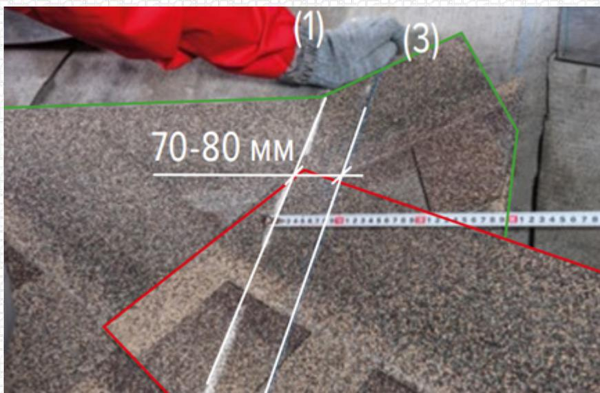
Подрезать рядовую черепицу с более крутого ската по мелованной линии подреза, используя специальную деревянную дощечку, чтобы не повредить целостность гидроизоляционного слоя.
