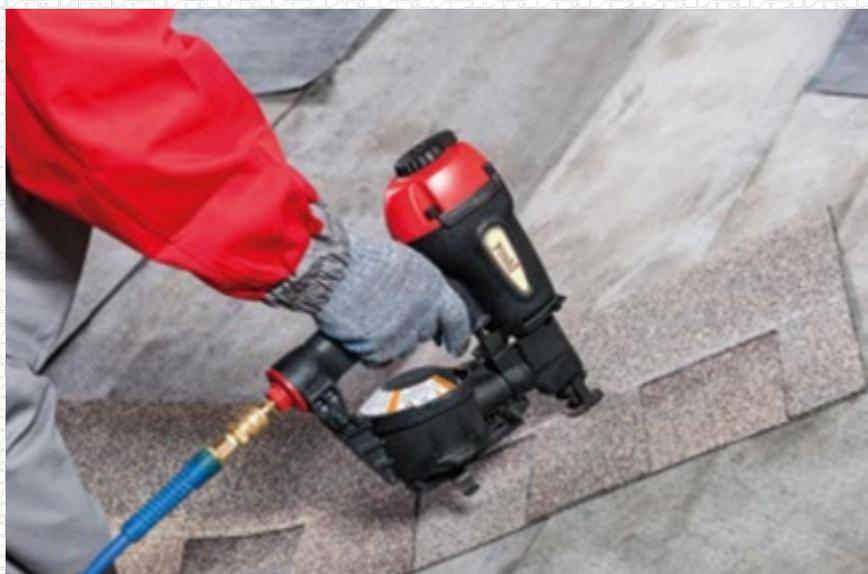
Не следует прибивать специальные гвозди ближе линии фиксации (2) (на расстоянии 300 мм от центральной оси ендовы (1)).
