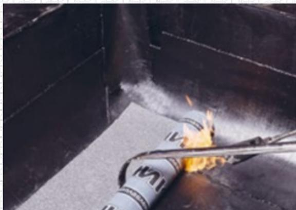
Подготовьте дополнительный верхний слой из материала Техноэласт ЭКП для заведения на плоскость парапета:
