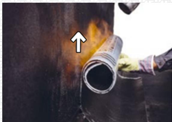
Наплавьте верхний слой из материала Техноэласт ЭКП.
