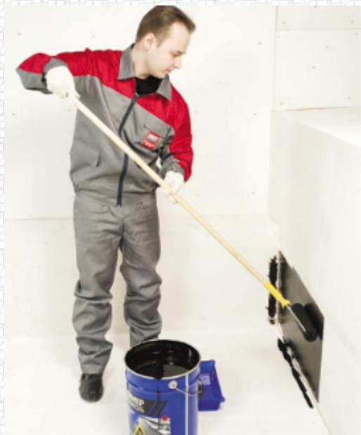
**Важно! В соответствии с СНиП 3.04.01-87 «Изоляционные и отделочные покрытия» Праймер ТЕХНОНИКОЛЬ № 01 наносится на монолитное основание с влажностью по массе не более 5%.**
