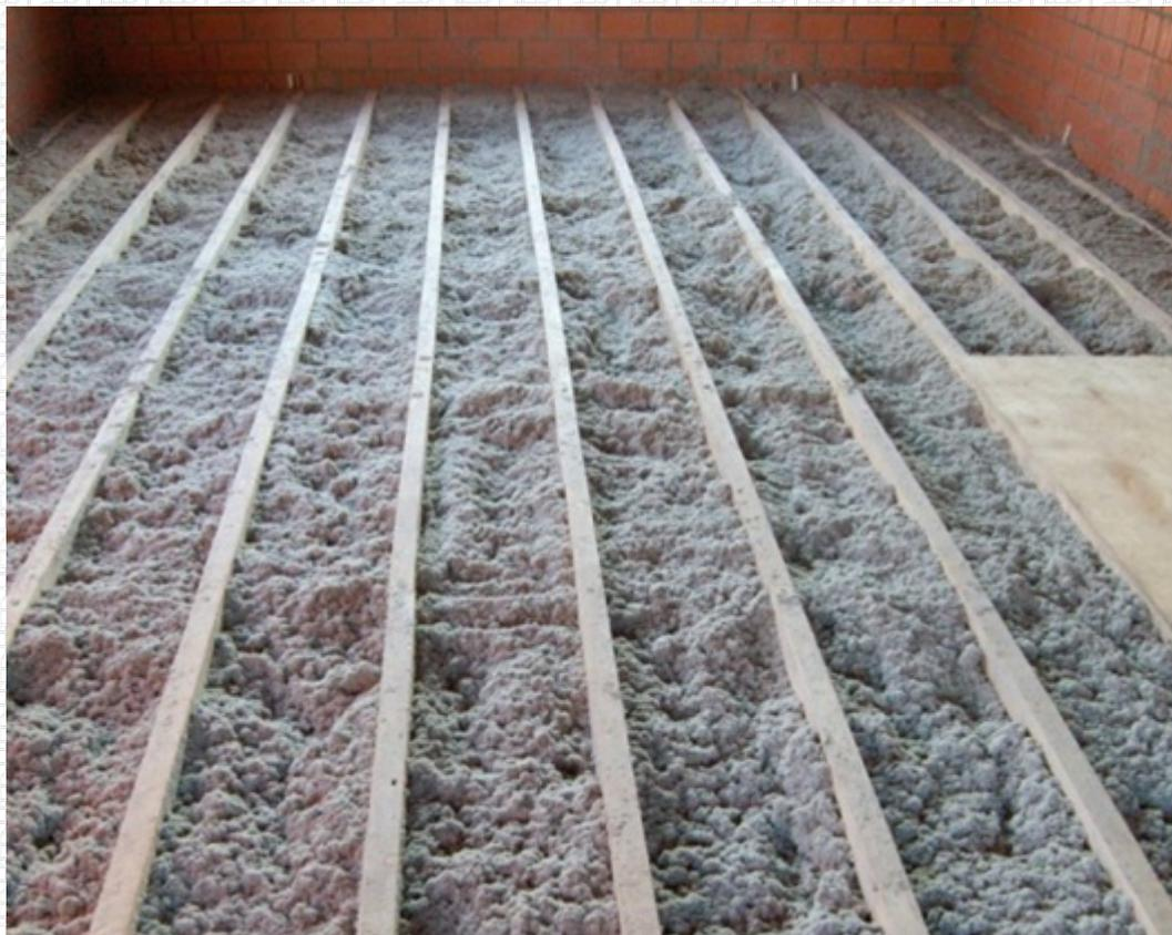
Данный материал похож по химической составляющей на PIR утеплитель, но при этом важно учитывать, что при распылении структура утеплителя не однообразна, что влияет в худшую сторону на теплопроводность.
