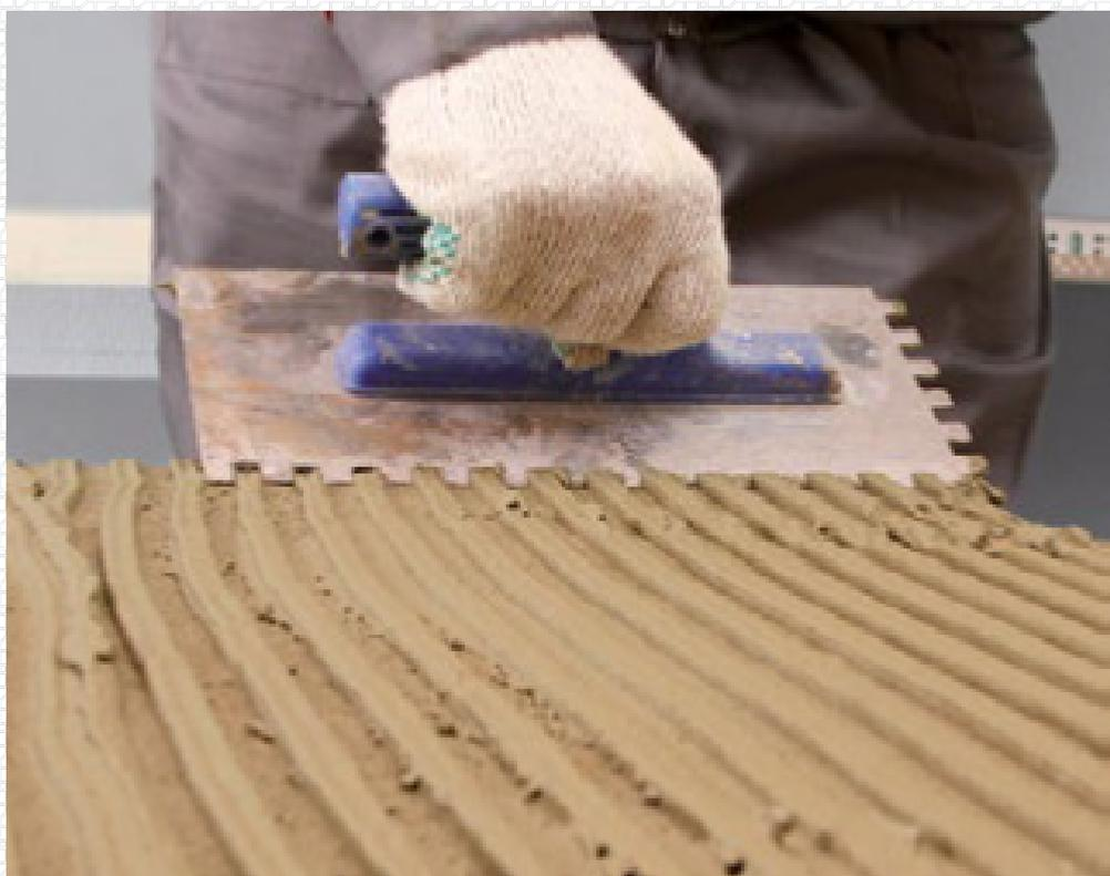
Для укрепления углов необходимо нанести клеевой раствор на поверхность плиты при помощи зубчатой терки. Затем установить угловой пластиковый профиль (профиль капельник по верхнему откосу), утопив его в растворе. Вдоль профиля необходимо уложить стеклосетку так, чтобы она заходила на обе плоскости от угла не менее чем на 150 мм, и утопить ее в клей при помощи плоской терки.
