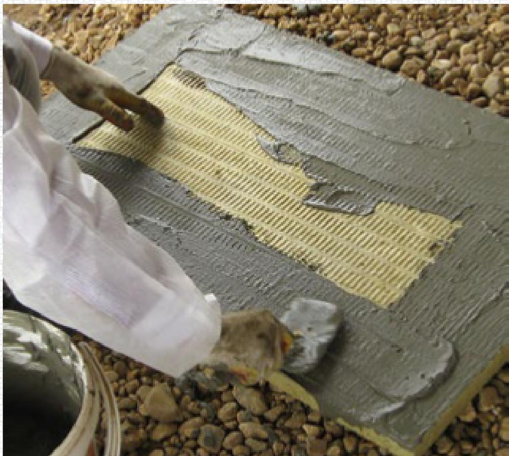
После высыхания клея между вставками из минеральной ваты и металлом к ним крепится основной слой огнезащитного покрытия с помощью клеевой смеси и гвоздей. Клей наносится на плиту при помощи шпателя в местах, где будет происходить контакт плиты с поверхностью металлоконструкции, вставками из минеральной ваты и прилегающими плитами. Толщина клеевого слоя должна составлять не менее 2 мм. Все стыки огнезащитных плит из каменной ваты дополнительно промазываются клеевым составом.
