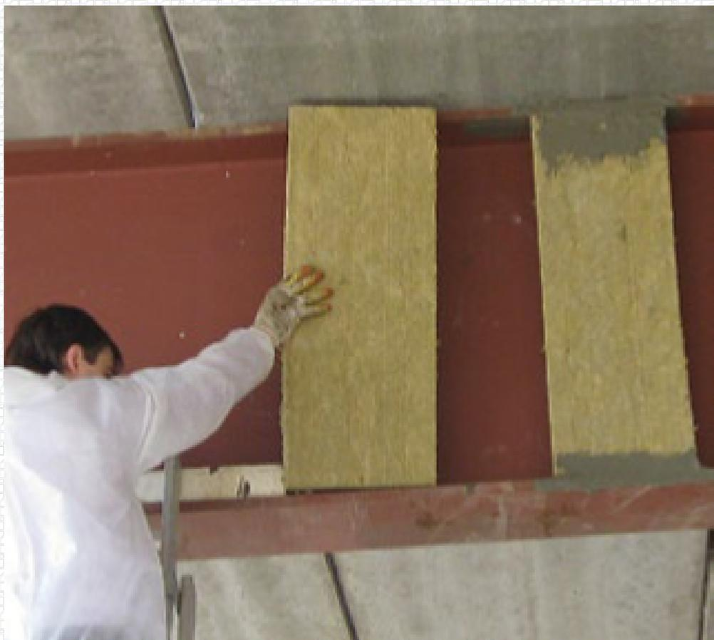
Для монтажа огнезащитной композиции на металлоконструкции сложной геометрической конструкции необходимо подготовить вставки из минеральной ваты размером не менее 100 мм по ширине и 30 мм по толщине. Вставки устанавливаются таким образом, чтобы стыки основных плит приходились на вставки, при этом шаг установки составлял не более 600 мм по оси.
