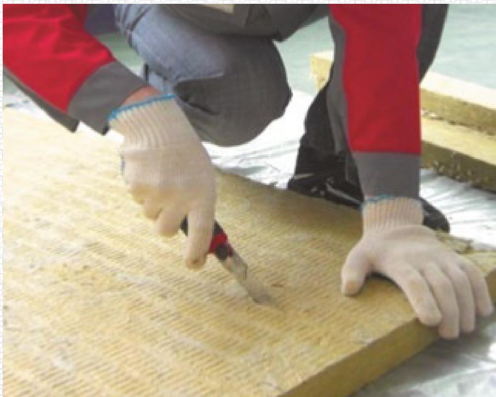
При помощи рулетки необходимо произвести замеры стальной конструкции и раскроить плиты ножом, либо на циркулярной пиле отрезными или алмазными кругами (без зубьев).
