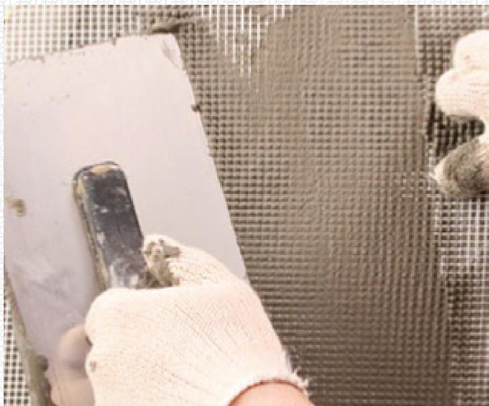
На свежий клеевой раствор нужно приложить подготовленный отрезок сетки, прижимая ее в нескольких местах к клею краем терки или пальцами. Гладкой стороной терки необходимо утопить сетку в клеевом растворе. Полотна стеклосетки соединяются внахлест 100 мм.
