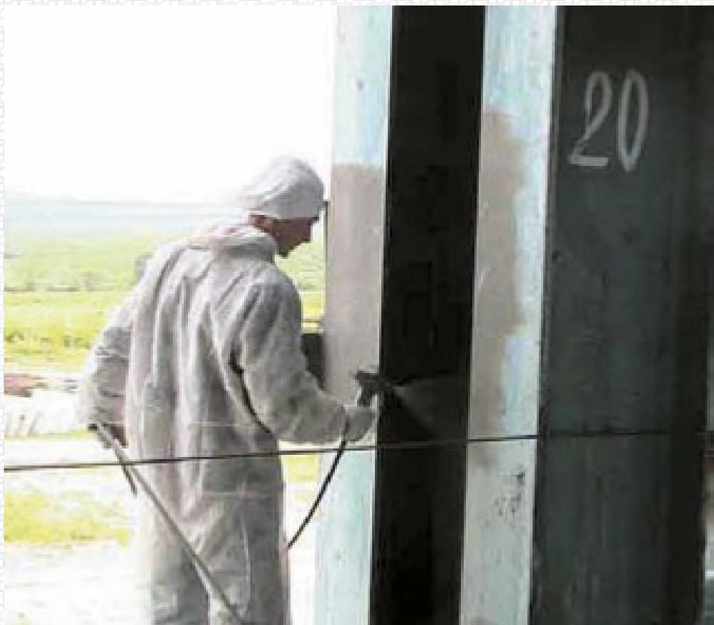
Стальная поверхность должна быть сухой и очищенной от загрязнений, масла и других компонентов, препятствующих плотному прилеганию огнезащитной плиты и адгезии клеевого состава. При необходимости поверхность требуется обезжирить спиртом или другим раствором и огрунтовать антикоррозийным грунтом. Грунт наносится ручным или механическим способом.
