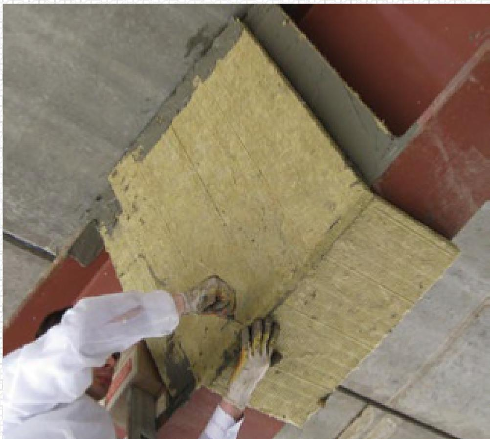
Плиты дополнительно фиксируются гвоздями, для предотвращения сползания плиты во время высыхания клея. Длина гвоздя должна быть в два раза больше толщины применяемого материала. Гвозди устанавливаются с шагом 200 мм, но не менее 3 шт. на вставку. После полного высыхания клея гвозди могут быть удалены или замазаны клеевым раствором, с целью предотвращения образования ржавчины на поверхности шляпки гвоздя в процессе эксплуатации.
