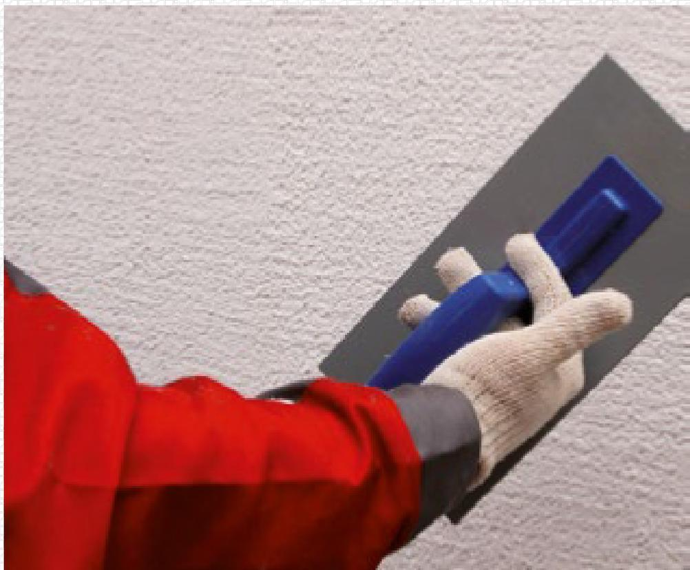
**Важно! К нанесению внешнего декоративного слоя можно приступать только после полного высыхания защитного армированного слоя, но не ранее чем через 72 часа (при температуре окружающей среды 20°C и относительной влажности воздуха 60%).**
