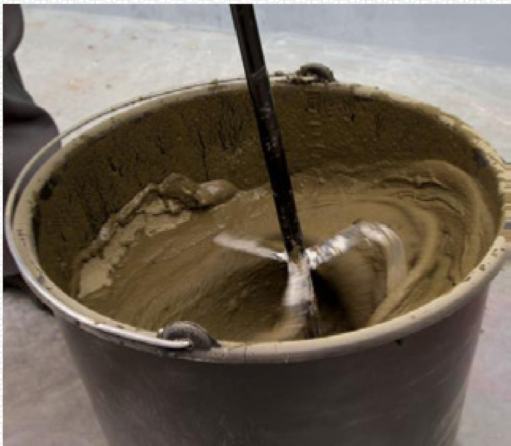
Затворить клеевую смесь водой в соответствии с рекомендациями производителя. Перед нанесением клей следует тщательно перемешивать до однородной массы в течение 2–3 минут. Температура применения клея должна быть выше +5°C. Время высыхания клея, в зависимости от температуры воздуха и уровня влажности, может составлять от 3 до 12 часов.
