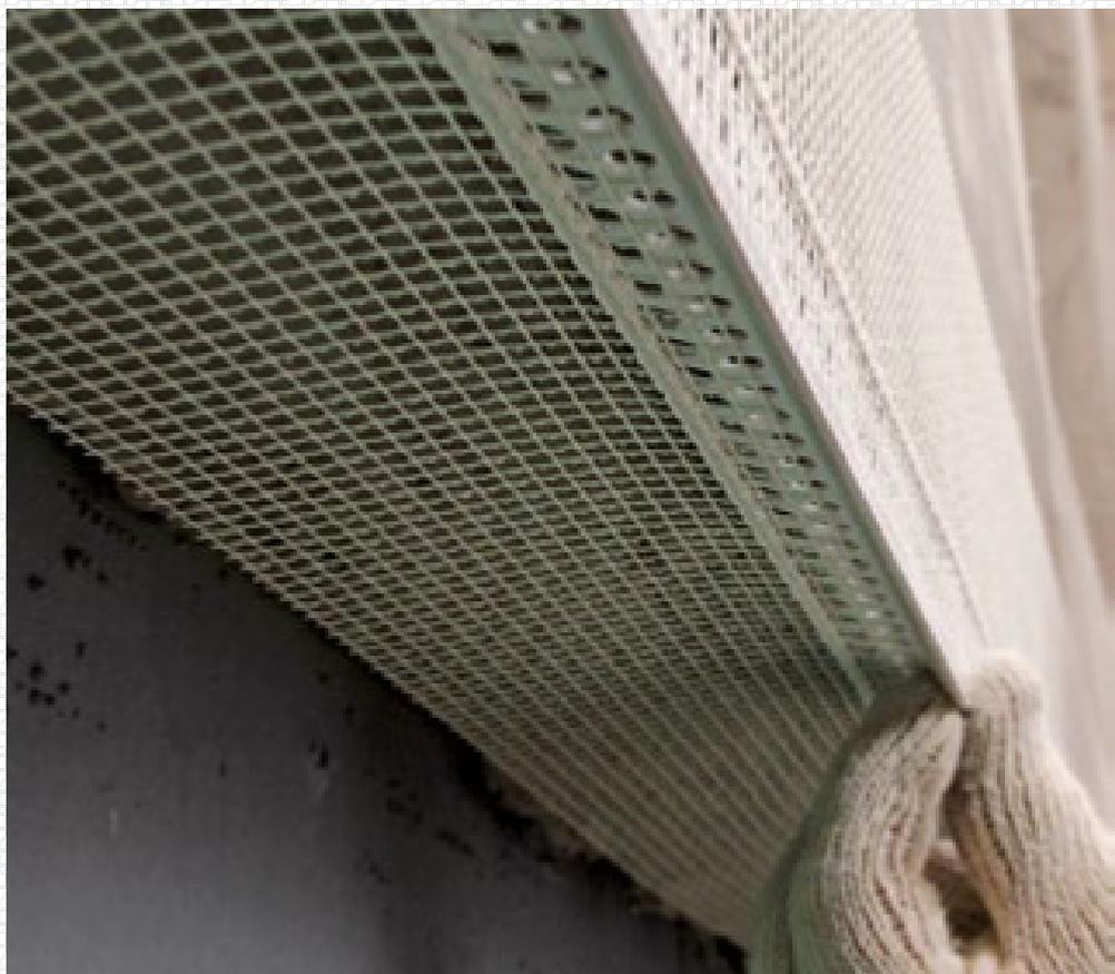
При применении композиции снаружи зданий и сооружений, необходимо защитить плиты из каменной ваты «Плита ТЕХНО ОЗМ» от воздействия атмосферных осадков. В качестве декоративно-защитного слоя может быть применено покрытие из минеральной штукатурки (по стеклосетке) или обшивка плитами ГКЛ, стальными кожухами и т.д.
