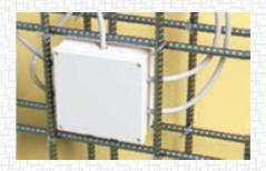
Если инъекционные трубки выводятся напрямую без применения распределительных коробок, то они обязательно должны быть защищены от механического повреждения и засорения строительным мусором и бетонной смесью. Следует предусмотреть защиту трубок как вовремя укладки бетонной смести, так и после ее отверждения. Для этого трубки можно «подвязать» к заранее установленной арматуре или смонтировать защитный короб из пиломатериалов или оцинкованной стали.
