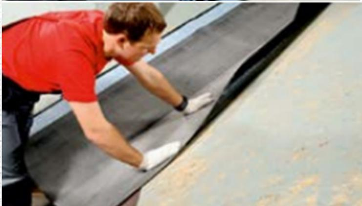
Эта часть подкладочного ковра приклеивается к основанию. В момент приклеивания следует аккуратно разглаживать полотно, избегая образования складок
