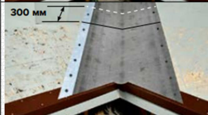
При возникновении нахлеста материала в зоне ендовы он выполняется в верхней ее части. Ширина поперечного перехлеста в зоне ендовы составляет 300мм.
