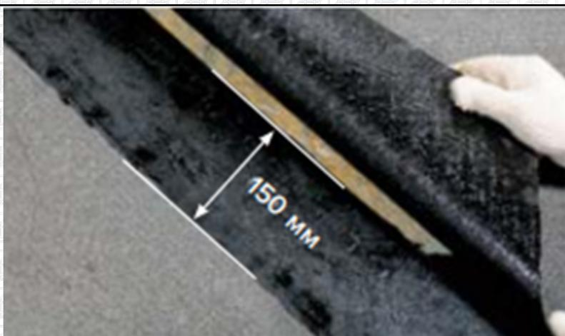
Поперечные нахлесты составляют 150мм. Место поперечного перехлеста подкладочного ковра ANDEREP ULTRA промазывается тонким слоем битумной мастики ТЕХНОНИКОЛЬ №23 (Фиксер). Формирование поперечного перехлеста подкладочного ковра ANDEREP NEXT SELF не требует применения мастики
