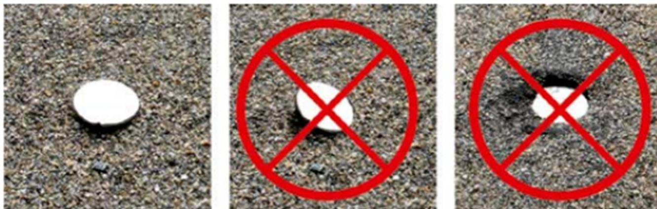
**ВАЖНО! Шляпка гвоздя должна плотно прижимать ковер к основанию, но не пробивать его. Перед непосредственным креплением подкладочного ковра гвоздем необходимо расправить и натянуть материал, чтобы на поверхности не было складок и неровностей.**
