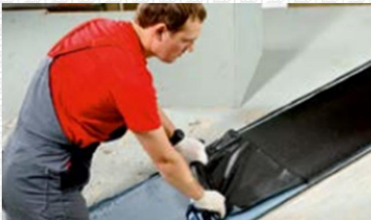
С одной части подкладочного ковра удаляется защитная пленка.
