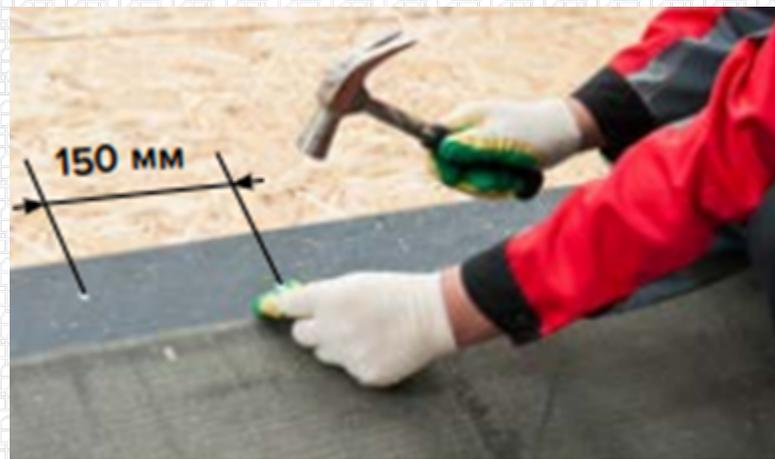
Выполнить механическую фиксацию материала ершеними кровельным гвоздями в зоне продольного перехлеста. Шаг крепления гвоздей составляет 150 мм и выполняется в разбежку
