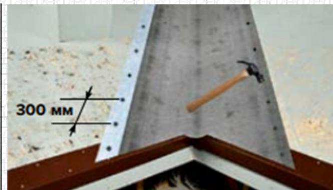
При температуре от 0 до +10 °С необходимо дополнительно закрепить подкладочный ковер кровельными гвоздями с широкой шляпкой. Расстояние между гвоздями составляет 300мм.
