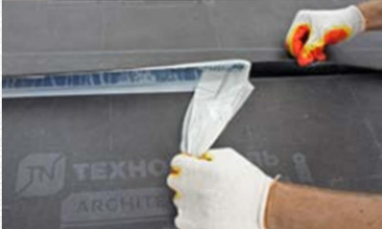
Продольный перехлест подкладочного ковра ANDEREP GL PLUS формируется с помощью клеевых монтажных полос. Для формирования перехлеста необходимо одновременно снять защитные пленки с клеевых полос верхнего и нижнего полотен и плотно прижать их друг к другу.
