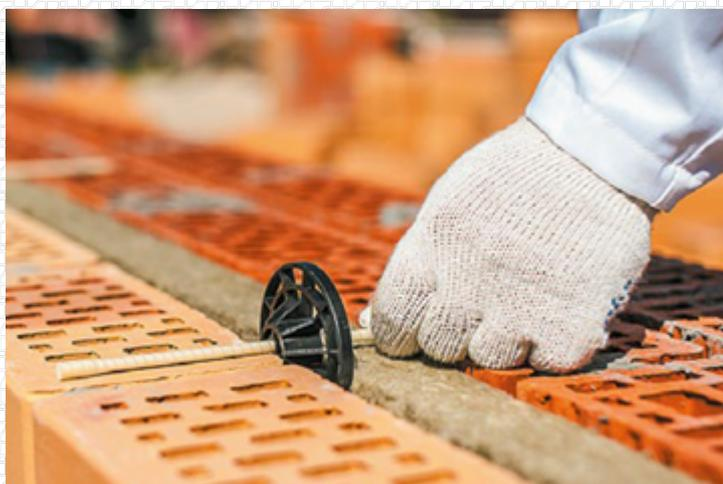
Чтобы наружный облицовочный слой не обрушился, его соединяют с внутренней кладкой гибкими связями — поперечными стержнями.
