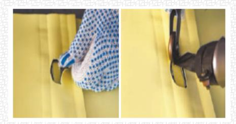
После того как проверочный канал «заглушен» посредством сварки, удалите непроверенную часть нахлеста для последующей установки заплатки.
