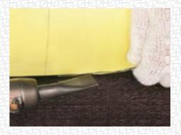
Еще один способ выполнения «запечатки» шва. В месте окончания шва «вскройте» образованный в процессе сварки проверочный канал «крючкообразным» ножом. Заварите проверочный канал, используя узкую насадку и латунный ролик.
