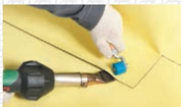
Вырежьте заготовку мембраны LOGICBASE V-SL таких размеров, чтобы она не менее чем на 50 мм перекрывала места разреза.
