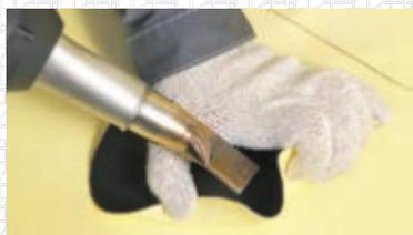
Приварите закругленный уголок заготовки сверху вниз и по бокам в стороны.
