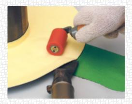
Вырежьте из неармированной мембраны V-SR полосу шириной **30-40 см**. Длина полосы должна быть больше длины окружности трубы на 4 см, чтобы обеспечить нахлест для получения сварочного шва.
