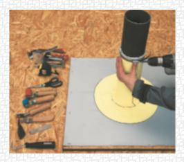
Затяните место примыкания металлическим хомутом.
