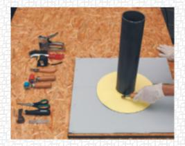
Приварите место перехода с вертикали на горизонталь с помощью фена, прикатывая латунным роликом. Снимите фаску с края заплатки на ширину сварного шва (не менее **30 мм**).
