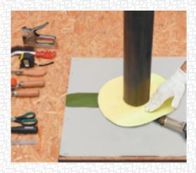
Окончательно приварите заготовку по внешнему краю. Проверьте качество сварки с помощью пробника.
