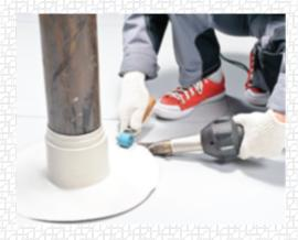
Проверьте качество сварного шва с помощью пробника.
