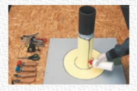
Проверьте качество выполненных швов пробником. Обработайте швы жидким ПВХ ТЕХНОНИКОЛЬ.
