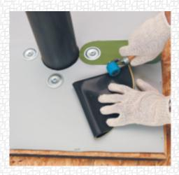
Нагревайте заготовку с обеих сторон вокруг отверстия с помощью фена до тех пор, пока мембрана не станет пластичной.
