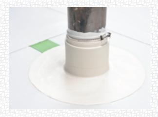
Срежьте верхнюю часть элемента по диаметру трубы. На ширину невостребованных диаметров выполнить обмотку трубы геотекстилем для исключения провисания.
