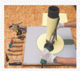
Снимите заготовку с трубы и закруглите ножницами нижний угол мембраны в нахлесте.
