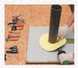
Приварите внутреннюю часть заготовки к основной мембране с помощью ручного фена.
