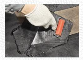
Элемент усиления должен быть качественно наплавлен. Одним из признаков качественного наплавления является вытекание битумной массы из-под боковой кромки материала сплошным валиком примерно на  $5 \div 25$  мм.
