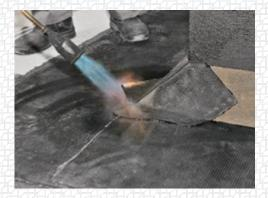
Прикатайте наплавленный материал силиконовым роликом.
