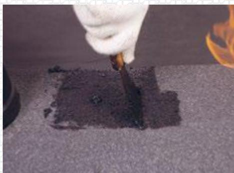
**Важно! Наплавление материала на крупнозернистую посыпку может повлечь протечки кровли.**
