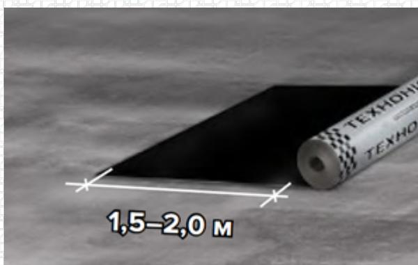
Наплавьте рулон на основание. При наплывении кровельного материала раскатывайте «рулон на себя».
