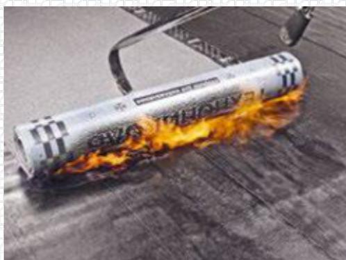
В случаях наплавления по крупнозернистой посыпке (торцевые, боковые нахлесты и т. п.) удалите посыпку из области наплавления:
