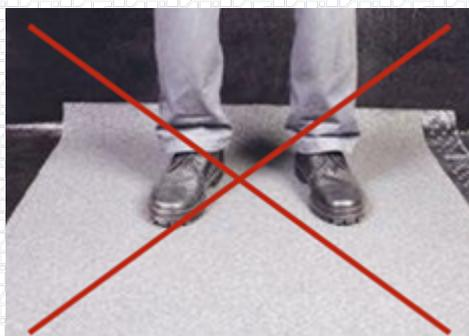
Посыпка утапливается в слой битумного вяжущего и на поверхности будут оставаться следы или участки с отслоившимся верхним слоем материала, что приведёт к ухудшению внешнего вида, ускоренному старению под воздействием солнечного излучения или механическому повреждению кровли.
