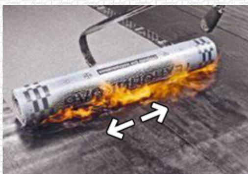
При наплавлении смежных рулонов траектория движения горелки должна описывать букву «Г», с дополнительным прогревом той области материала, которая идет внахлест.
