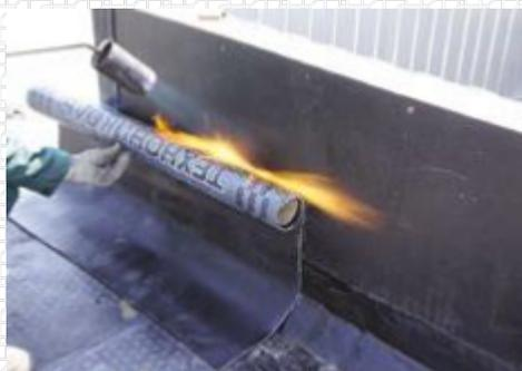
Для качественного наплавления на основание необходимо добиться небольшого валика битумно-полимерного вяжущего в месте соприкосновения материала с поверхностью.
