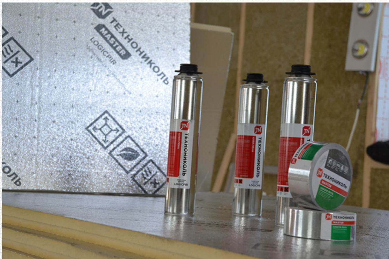
К внутренней поверхности деревянных стоек подшиваются большие плиты из вспененного полиизоцианурата марки [LOGICPIR PROF](#). Между стойками заложены минераловатные плиты.
