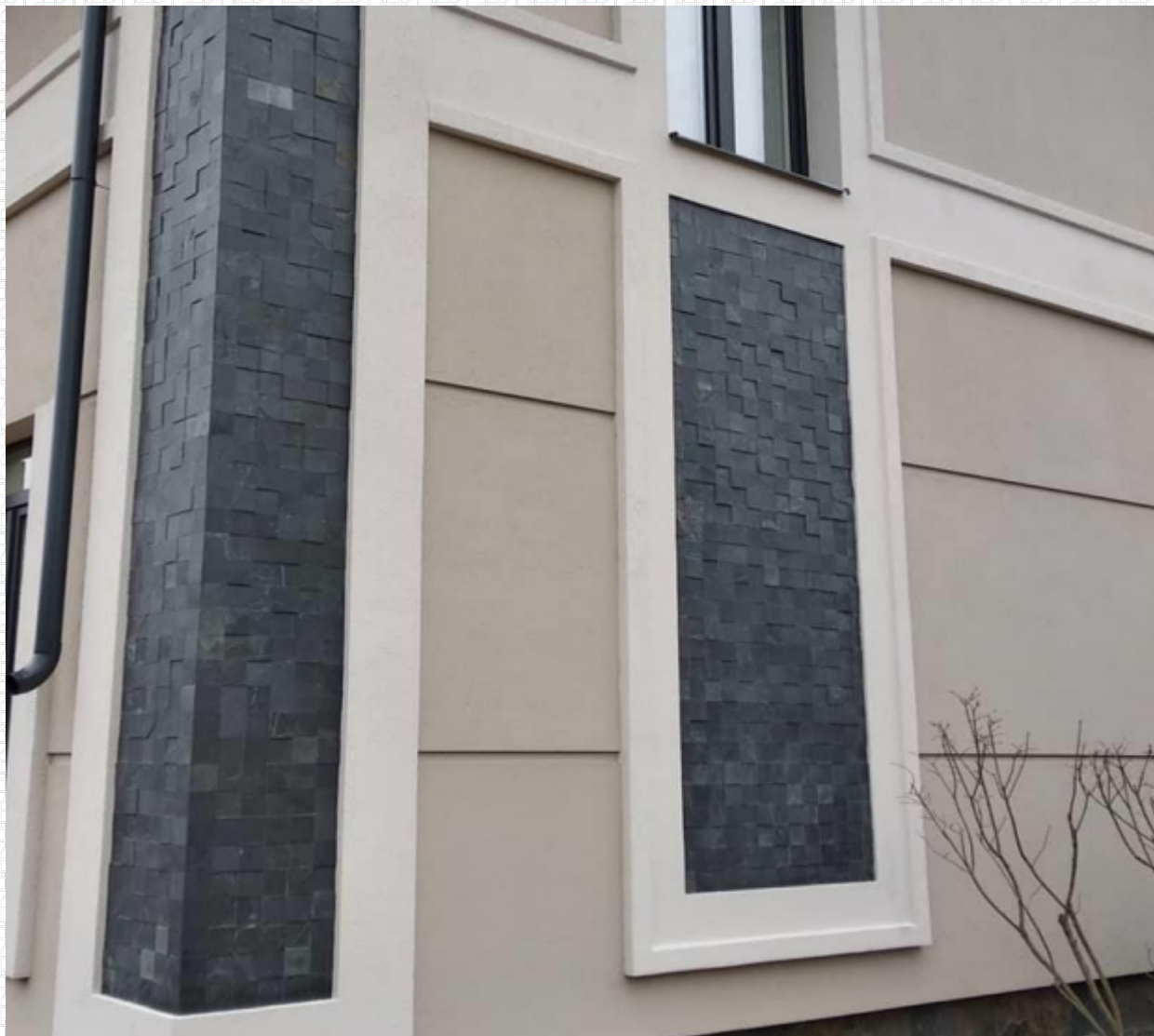
Штукатурный фасад со вставками из натурального колотого сланца
