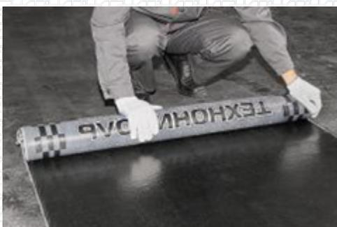
Наплавление производите, оплавливая нижнюю поверхность рулона пламенем горелки и одновременно подогревая поверхность основания. Нагрев производят плавными движениями горелки, уделяя особое внимание зонам нахлеста, постепенно раскатывая рулон на себя.
