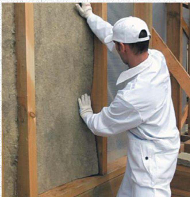
В качестве утеплителя в каркасных зданиях чаще всего применяются плиты из минеральной ваты, которые имеют ряд преимуществ перед утеплителями из целлюлозной ваты или пенополистирола, главным из которых является пожарная безопасность.
