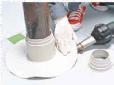
Снимите фаску с краев готового элемента на ширину сварного шва (не менее 30 мм).
