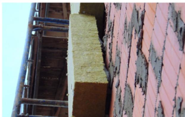
**Когда проводить монтаж утеплителя.** Установка производится в температурном диапазоне от +5°C до +30°C, с влажностью воздуха не более 75%. Если выполнять монтаж с нарушениями Технологической Карты системодержателя, то в процессе эксплуатации могут появиться различного рода дефекты. Придется проводить капитальный ремонт фасада.
