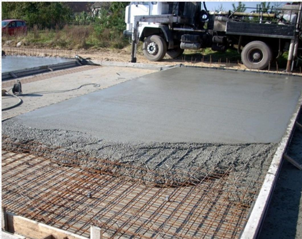
Монолитная плита пола по грунту – это конструкция, изготовленная на месте строительства здания путем заливки арматуры бетонной смесью. При этом, арматура находится на всей площади перекрытия, не доходя до края 4-5 см.
