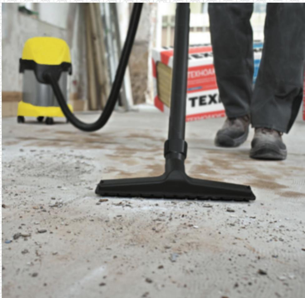
К началу работ по тепловой и звуковой изоляции помещения все мокрые процессы в помещении должны быть завершены.
