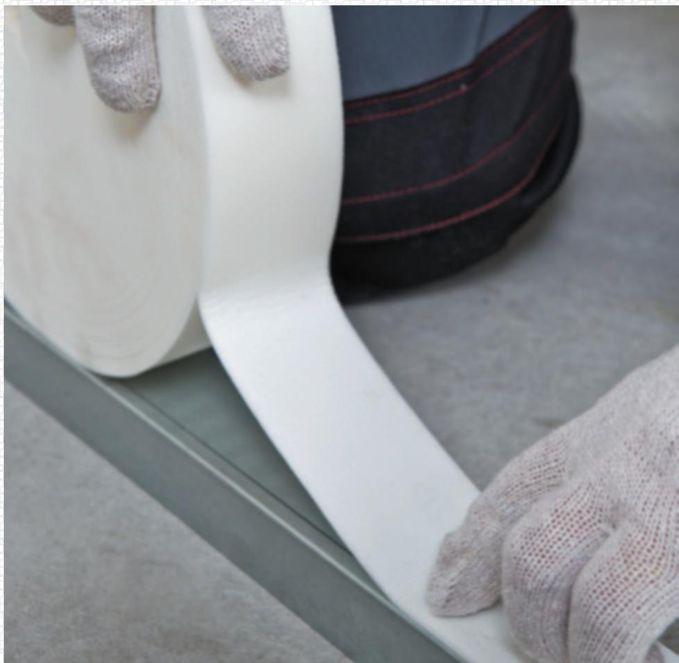
Закрепить направляющий профиль к полу, стенам и потолку согласно разметке.
