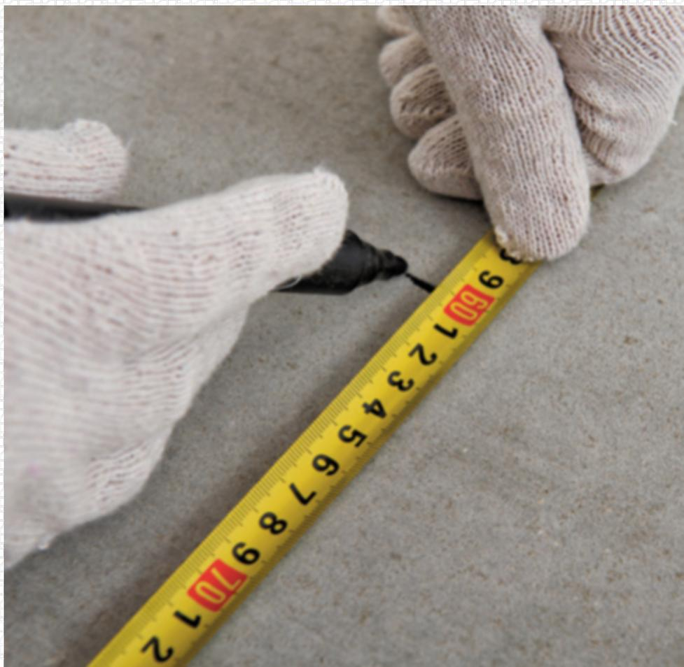
Для устройства разметки основания рекомендуется использовать лазерный уровень, отбивочный шнур или строительный уровень.
