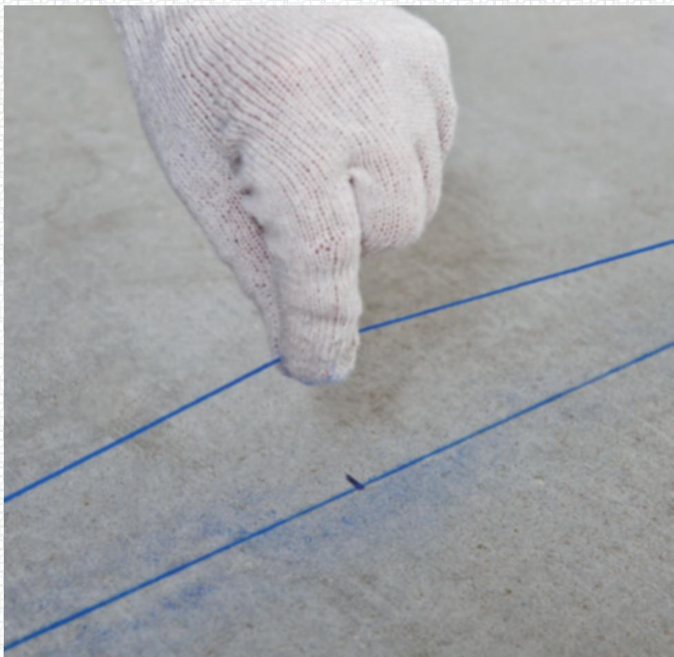
Разметку необходимо выполнить на полу, стенах и потолке, согласно проекту будущей перегородки. Для соединения точек и выполнения разметки следует использовать отбивочный шнур. Разметку пола и перенос отметок надлежит осуществить также с помощью отбивочного шнура.
