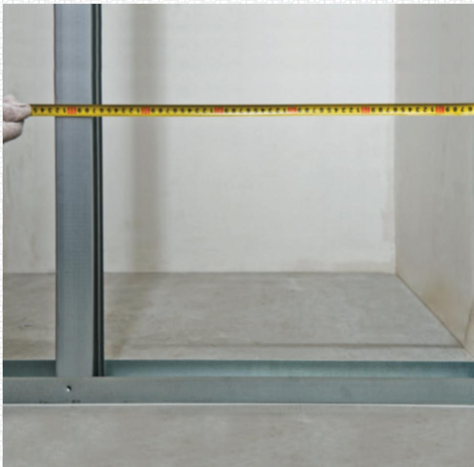
Профиль установить таким образом, чтобы стенки соседних профилей были ориентированы в одну сторону.
