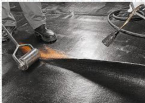
При необходимости наплавьте второй слой РБМ методом полной приклейки к первому слою, соблюдая расстояние между краями рулонов первого и второго слоя (не менее 300 мм), а также боковые и торцевые нахлесты.
