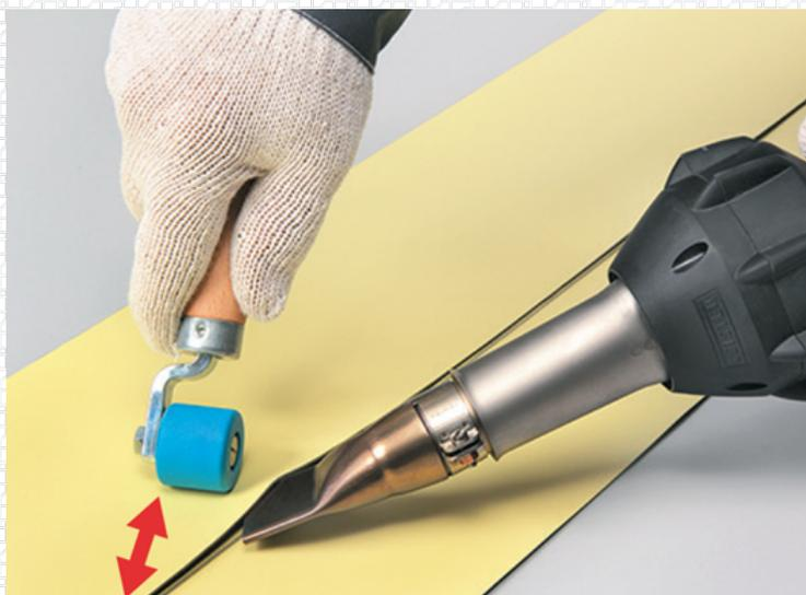
При этом ширина сварного шва (место гомогенного соединения двух слоев мембраны) должна составлять не менее 30 мм.
