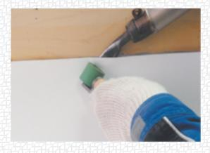
Для дополнительной герметизации узла нанесите ПУ герметик ТЕХНОНИКОЛЬ на край планки.
