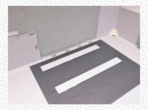
Поместите дополнительную рейку в кармане. При закреплении крайнего крепежа тяните мембрану за угол по диагонали, чтобы избежать образования волны на мембране.
