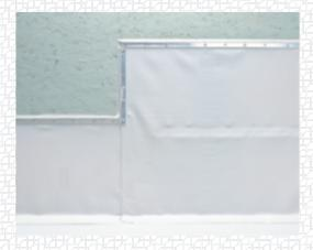
Проверьте качество сварных швов пробником. Швы, сделанные вручную, обработайте жидким пвх.
