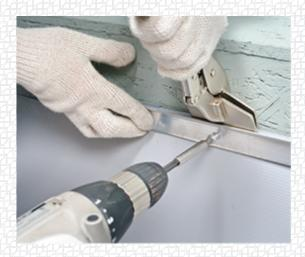
Для крепления краевой рейки к парапету, выполненный из сэндвич-панели, необходимо применять крепеж с толщиной наката не менее 5,5 мм. Для выполнения примыкания к парапету при помощи ПВХ металла нарежьте планки шириной 50 мм при помощи ручных или электрических ножниц по металлу. Также можно использовать готовые ПВХ планки.
