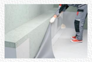
Если высота заведения мембраны на парапет составляет более 450 мм либо нужно сделать парапет со слоем доутепления, используйте для крепления дополнительный скрытый карман с рейкой.
