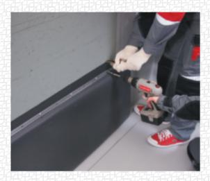
В случае низкого парапета (обычно высотой 350 мм) перекиньте мембрану через парапет и, натягивая наружу одной рукой, второй рукой выглаживайте мембрану вверх, чтобы избежать появления волны.
