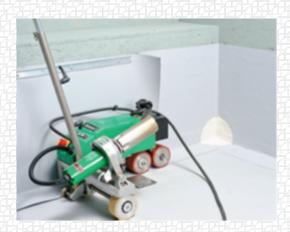
Приварите все нахлесты. На горизонтали предварительно снимите фаску с края нижней мембраны.
