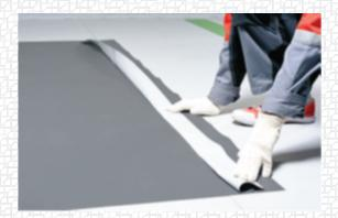
Вставьте прижимную рейку в «скрытый карман» и натяните мембрану «кармана» с помощью «зажима кровельщика», одновременно давя на рейку плоскогубцами. При креплении подкладывайте под крепеж металлическую пластину, чтобы избежать повреждения мембраны.
