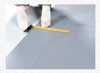
Подготовьте также узкую полосу армированной мембраны V-RP шириной 120 мм для изготовления «кармана». На изнаночной стороне полосы «парапетной» мембраны начертите линию на расстоянии 80 мм от нижнего края полотна и по ней выровняйте полоску для «кармана». Для получения «кармана» возможно использование специального готового элемента.
