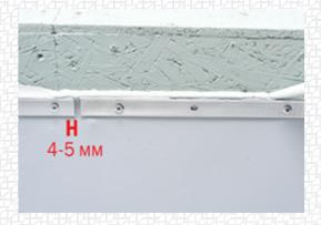
При креплении на наружном и внутреннем углах между краевыми рейками оставьте зазор в 4-5 мм. Края реек усильте дополнительным креплением.
