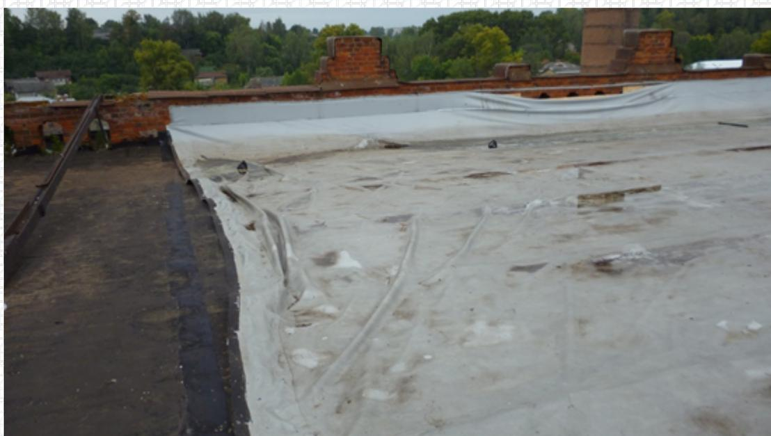
От расчета ветровой нагрузки сильно зависит количество крепежных элементов и ширина рулонов мембраны. Чем выше ветровая нагрузка, тем больше нужно крепежей на  $1 \text{ м}^2$ , при этом ширину мембраны необходимо уменьшать, чтобы нужное количество крепежа можно было поместить в шов мембраны. Из-за этого вырастает коэффициент расхода.
