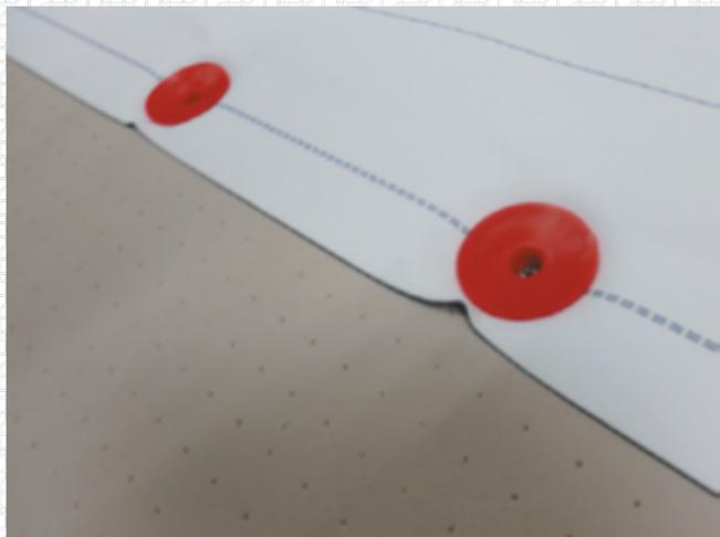
Выполните сварку шва автоматическим оборудованием.
