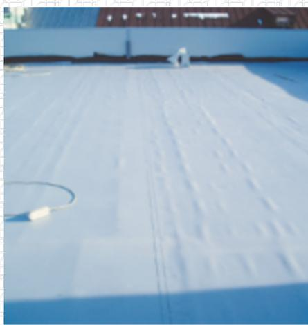
**ВАЖНО! Сила натяжения мембраны зависит от температуры на кровле. Не следует натягивать мембрану слишком сильно при температурах окружающего воздуха свыше +30°C, поскольку это может привести к появлению чрезмерных напряжений в мембране при отрицательных температурах в зимнее время.**
