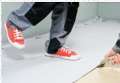
В случае необходимости для дополнительного натяжения в месте крепления используйте «зажим кровельщика».
