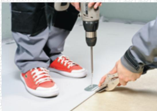
Крепление осуществляйте в маркерную линию, нанесенную вдоль каждого рулона мембраны **LOGICROOF** и **ECOPLAST**.
