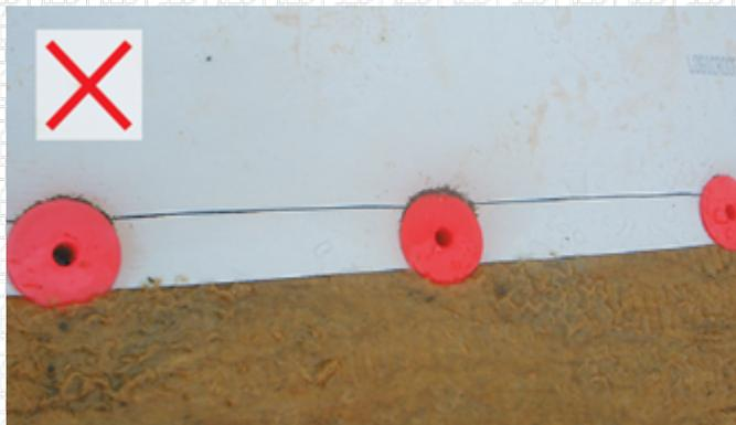
Установка крепежа близко к краю полотна может привести к разрыву мембраны в местах крепления под действием ветровых нагрузок.
