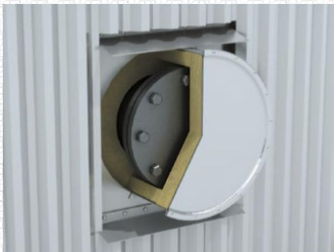
Из покровного материала формируется короб высотой, равной высоте смотрового люка плюс толщина теплоизоляции, и диаметром, равным диаметру люка плюс две толщины теплоизоляции. Внутренняя плоскость короба заполняется теплоизоляционным материалом, и короб крепится к основанию при помощи саморезов 4,2×13 мм с шагом 150 мм.
