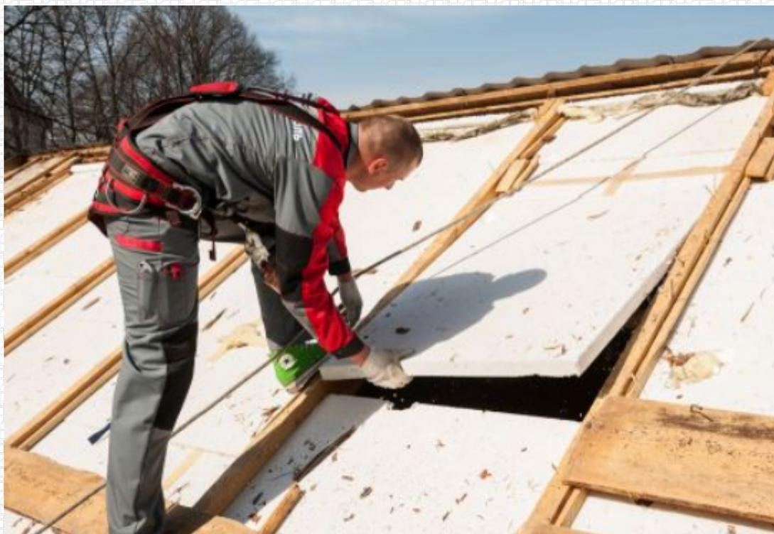
Не менее важно оценить достаточно ли сечение стропил и их шаг под выбранную кровлю и при необходимости обустроить новую стропильную систему. Кровельный материал и вид утеплителя определяют слои кровельного пирога. В качестве примера рассмотрим процесс обустройства скатной крыши, утепленной PIR-плитами и покрытой гибкой битумной черепицей.
