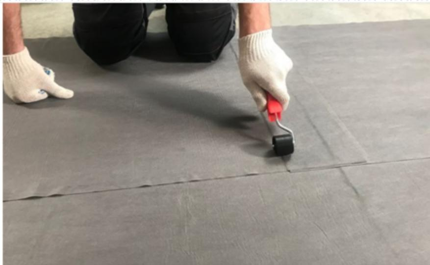
Помимо того, что гидроизоляция укладывается на всю поверхность пола, она в обязательном порядке должна заходить на стены на высоту 200 мм. Для этого понадобятся полосы шириной 300 мм: 200 мм останутся в вертикальной плоскости, а 100 мм сформируют нахлест с горизонтальной поверхностью.
