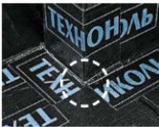
Для дополнительной герметизации приклейте заплатку в место сопряжения угла стены (перегородки) и горизонтального основания.
