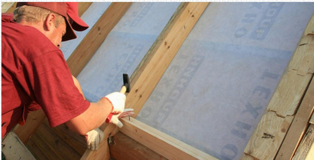
Поверх плёнки с наружной стороны укладываем утеплитель, толщиной определённой теплотехническим расчётом.
