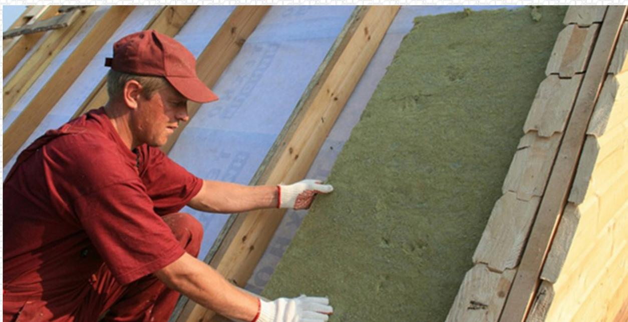
Укладку плит из утеплителя по возможности осуществляем в разбежку.
