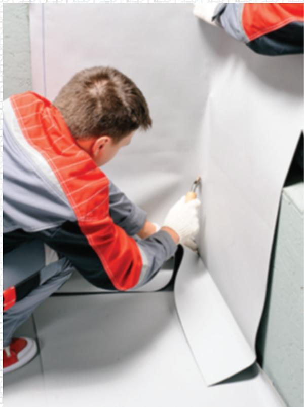
Далее прикатайте мембрану к поверхности парапета с помощью силиконового ролика.
