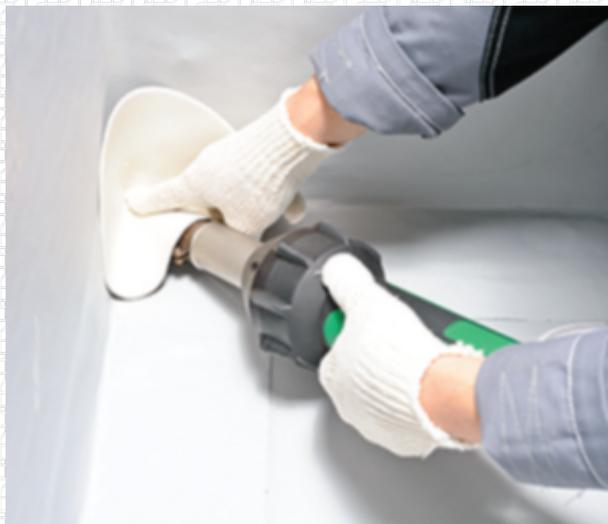
Проварите радиусы элемента с помощью латунного ролика.
