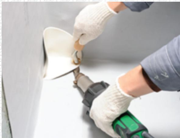
Аналогично приварите элемент во всех плоскостях. Проверьте качество сварного шва пробником, горизонтальную часть шва обработайте жидким ПВХ ТЕХНОНИКОЛЬ.
