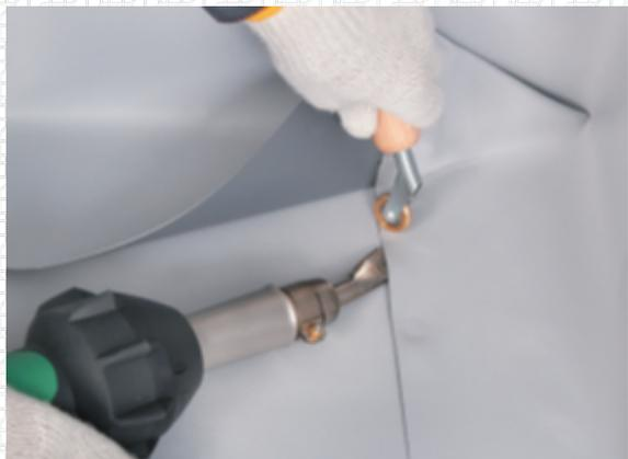
Далее приварите нахлест мембраны к основному кровельному ковру обычным образом с помощью силиконового ролика.
