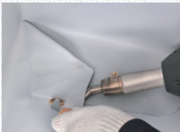
Особенно тщательно приварите границу стыков и начало сварного шва между нахлестом и основным кровельным ковром.
