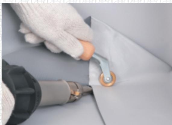
Приварите шов в месте перехода из «конверта» в нахлест мембраны при помощи латунного ролика.
