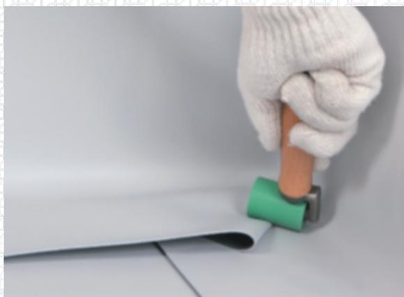
Для избежания повреждения нижних слоев материала подложите под петлю из мембраны металлическую пластину с обработанными краями толщиной 0,3-0,5 мм из оцинковки или нержавеющей стали и сделайте прихватку.
