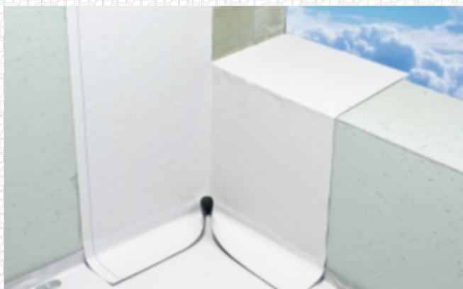
Загните нижние нахлесты заготовки для угла. Под заготовку желательно настелить кусок мембраны, чтобы не испачкать клеем основной кровельный ковер.
