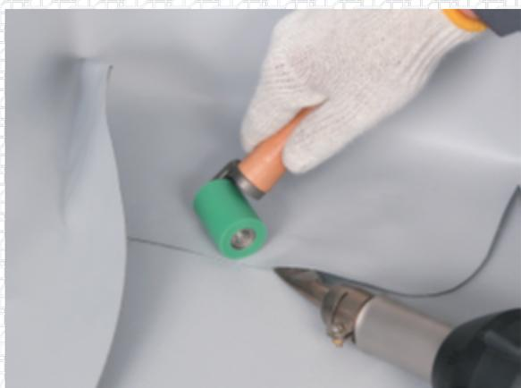
С помощью узкого латунного ролика приварите место перехода с нахлеста мембраны в «конверт».
