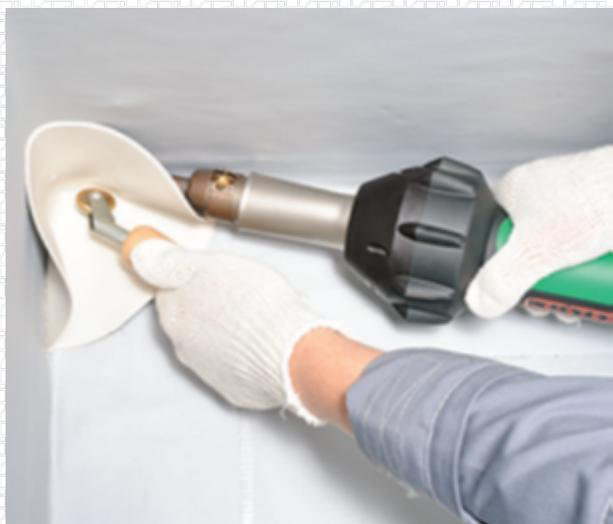
Выварите основную площадь готового элемента.
