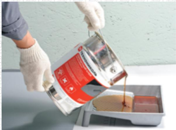
Нанесите на один из парапетов толстый слой контактного клея при помощи валика.
