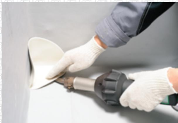
Доварите края элемента узким латунным роликом.
