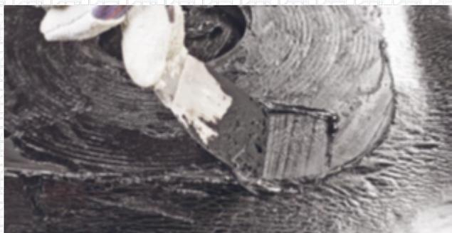
6. Наплавьте верхний слой кровельного материала Техноэласт ЭКП.
