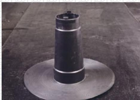
Уложенный материал Унифлекс ВЕНТ ЭПВ и основание под водоизоляционный ковер, выполненное из стяжки, может быть прорезано по диаметру трубы аэратора до теплоизоляционного слоя или уклонообразующего слоя из керамзитового гравия. При устройстве новой кровли достаточно прорезать материал Унифлекс ВЕНТ ЭПВ по диаметру трубы.
