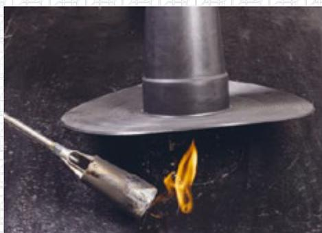
3. Установите аэратор и вдавите «юбку» в разогретый материал. Следите за равномерным вытеканием битумно-полимерного вяжущего из-под фланца аэратора. Вытек обеспечит полную герметичность соединения.
