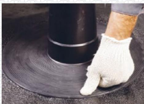
4. Закрепите кровельный аэратор в основании, используя минимум 4 крепежных элемента. В качестве крепежных элементов применяйте остроконечные саморезы ТЕХНОНИКОЛЬ EDS-S 4,8 мм с полиамидной гильзой.
