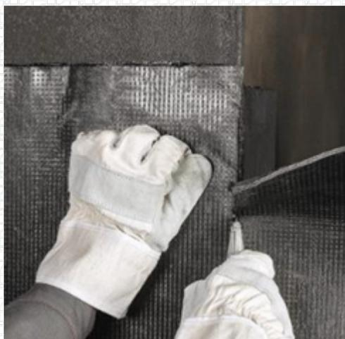
Аналогичным образом выполните подгонку второго рулона и произведите его наплавление.
