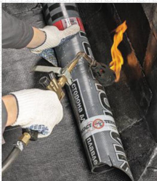
Наплавленный рулон должен выглядеть следующим образом:
