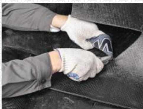
Отрежьте ненаплавленную часть рулона до уровня фундаментной плиты.
