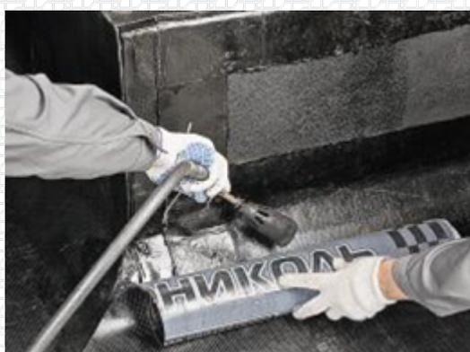
Наплавленные рулоны первого слоя должны выглядеть следующим образом.
