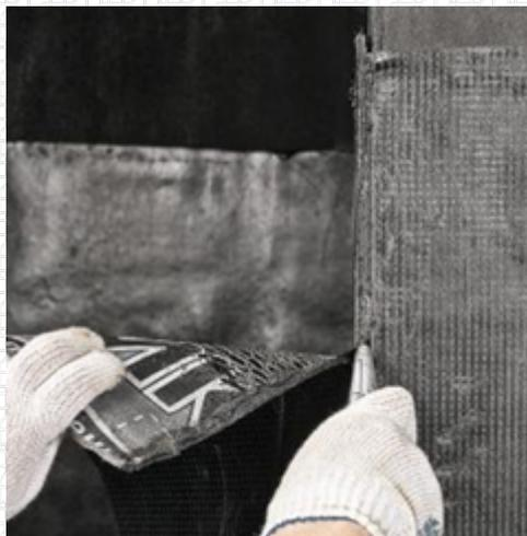
Наплавленные рулоны должны выглядеть следующим образом. После этого выполните наплавление первого слоя вертикальной гидроизоляционной мембраны по всему периметру сооружения.
