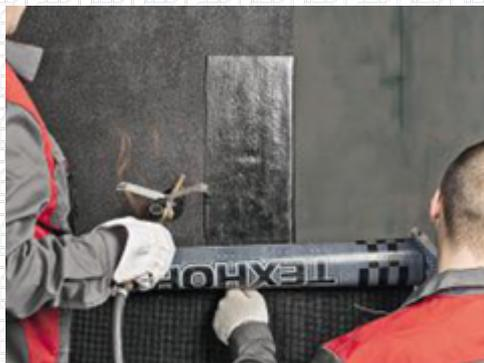
После наплавления свободный (ненаплавленный) край рулона отрежьте кровельным ножом до уровня фундаментной плиты.
