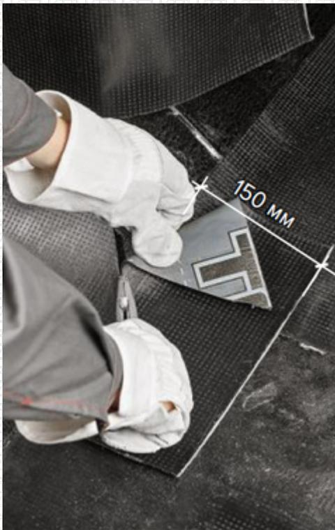
Скатайте материал в рулон и наплавьте его на конструкцию по направлению снизу вверх.
