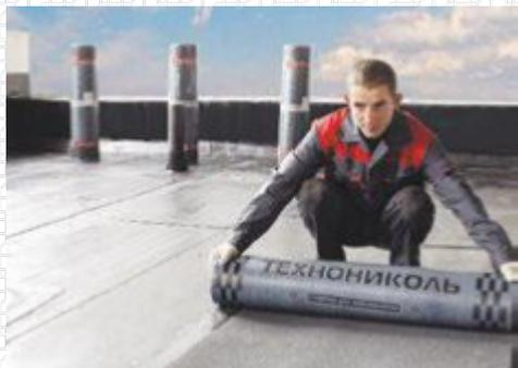
Для того, чтобы рулон не смещался в процессе выравнивания, и для того, чтобы не образовывались волны на рулоне, необходимо, чтобы кровельщик встал на один конец рулона, а другой кровельщик выравнивал рулон, контролируя нахлесты.
