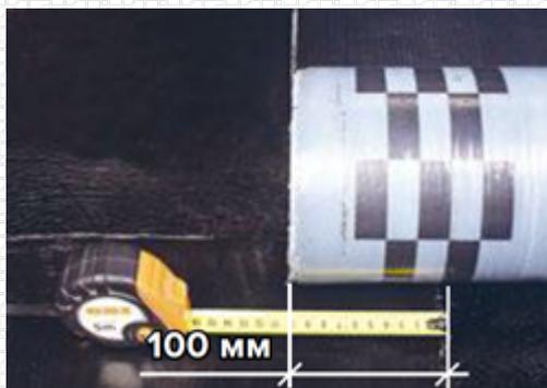
Соблюдайте порядок раскладки материала в боковых нахлестах от самых низких точек кровли к самой высокой для предотвращения противозовки. Вода должна стекать со шва в сторону водораздела.
