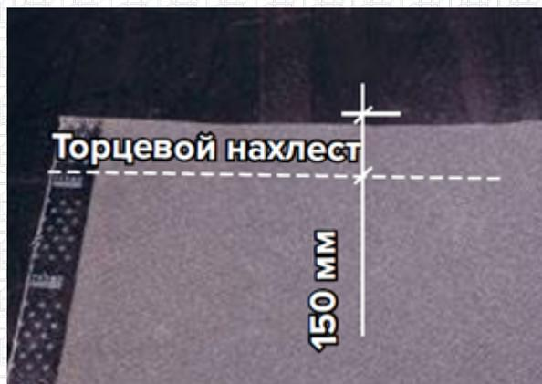
Во избежание противотокки соблюдайте правильный нахлест торцевого шва. Вода должна стекать со шва в сторону водоприёмной воронки.
