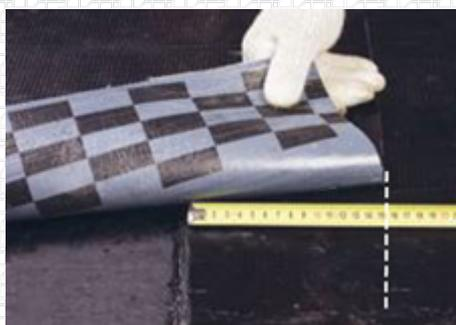
Во избежание противозовки соблюдайте правильный нахлест торцевого шва. Вода должна стекать со шва в сторону водоприёмной воронки.
