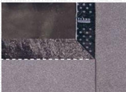
Торцевые нахлесты соседних полотенц кровельного материала Техноэласт ЭКП должны быть смещены относительно друг друга не менее чем на 500 мм:
