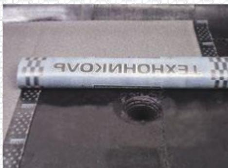
Специально для бокового нахлеста на каждом материале Техноэласт ЭКП имеется полоса без крупнозернистой посыпки.
